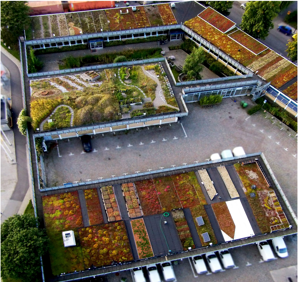
Flygbild av de tak som finns på Gröna tak-institutet i Augustenborg i Malmö. Foto: Scandinavian Green Roof Institute.
