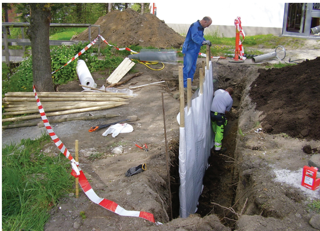
Vid mera omfattande schaktningar grävs ett vitaliseringsdike. Foto: Örjan Stål.
