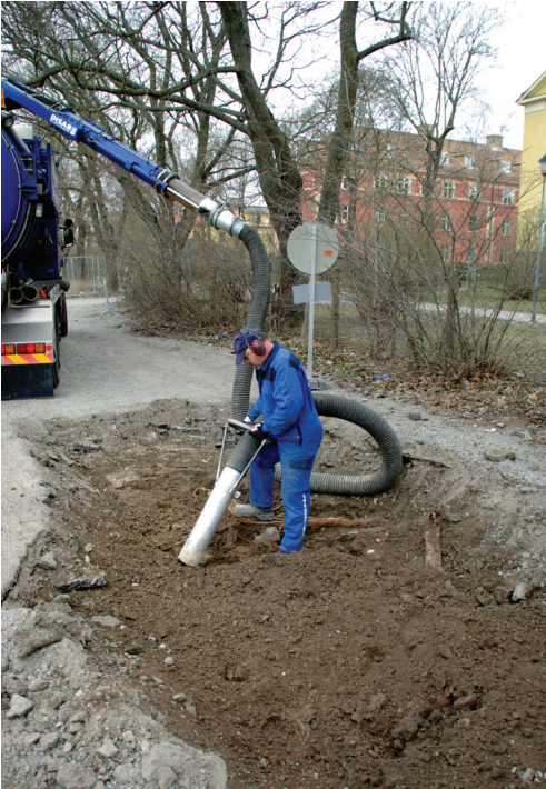
Vid rotkartering blottläggs rotsystemet genom att jorden sugts bort i det översta markskiktet. Foto: Örjan Stål.
