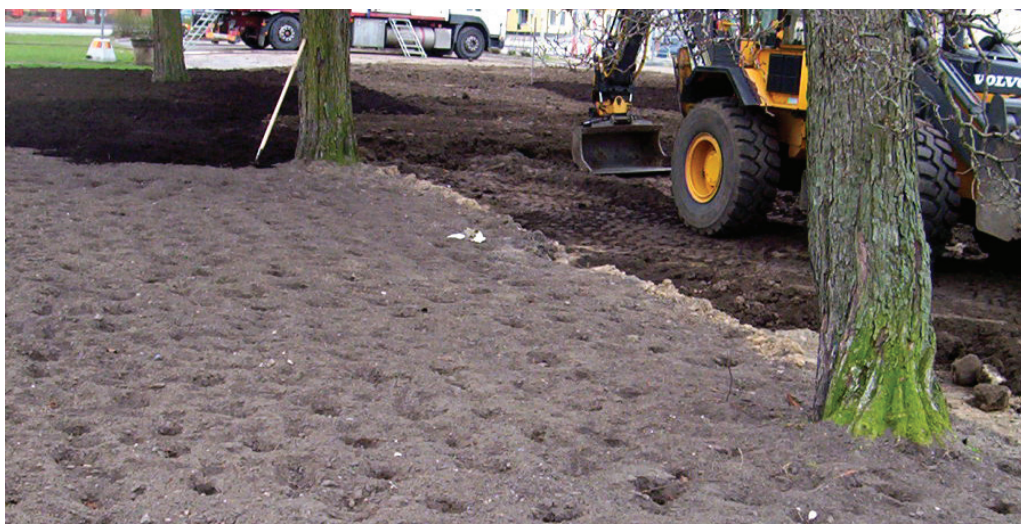
Vid en markvitalisering ges bättre förutsättningar till rotutveckling i det översta marklagret. Foto: Örjan Stål.
