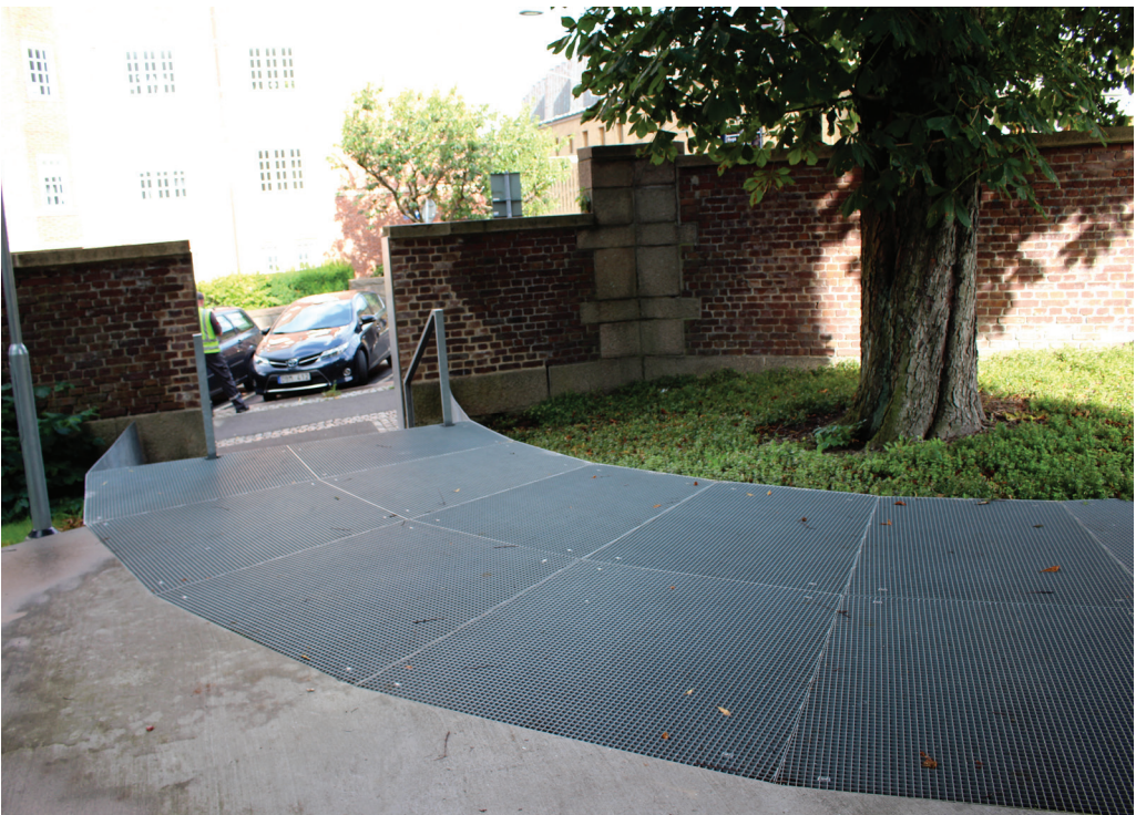
En brokonstruktion ökar bärigheten vid ett träd. Foto: Örjan Stål.
