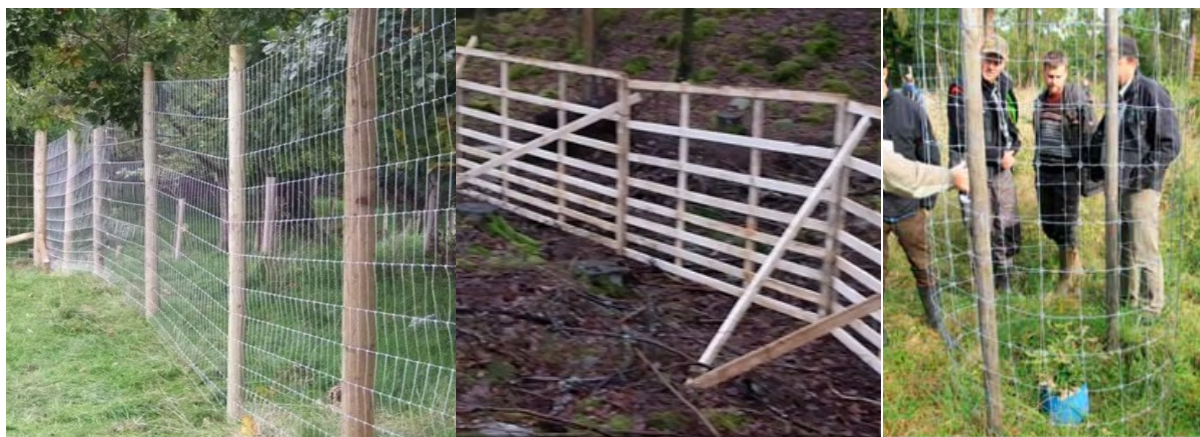
Figur 21. Höga stängsel för att skydda lövträdsplanteringar mot hjort, rådjur och älg. Från vänster nätstängsel, trästängsel och ”Ståålburen” (uppkallad efter ekforskaren Erik Ståål). För skydd mot nötkreaturs och fårs tryck när de försöker komma åt gräs torde Ståålburen behöva modifieras så att den får flera stolpar runt vilka nätet spänns hårt. Men för att skydda mot nöt och får behöver ”buren” inte vara lika hög som på bilden.
