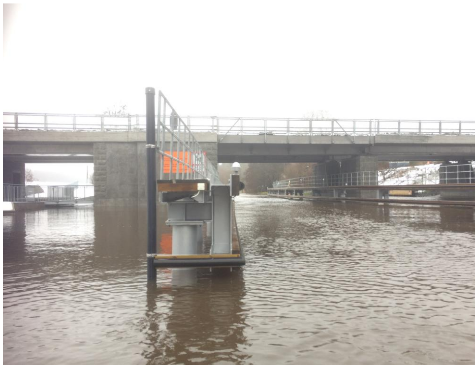
Figur 11. Installation av sond i lodrätt rör vid ett brofäste i Fyrisån, Flottsund.
