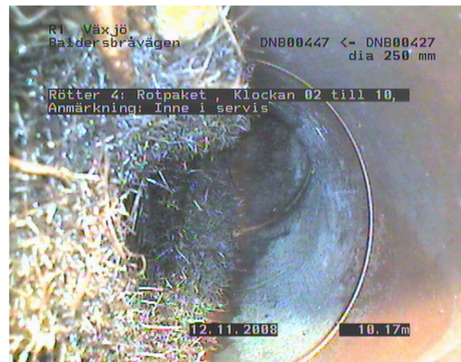
Foto inifrån en VA-ledning i Växjö.
