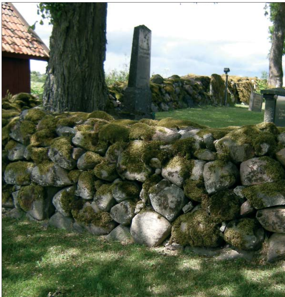
Kallmur av fältsten, det vill säga obearbetad sten från omgivande mark. Muren fungerar som både avskiljare och stödmur. Foto: Catharina Svala
