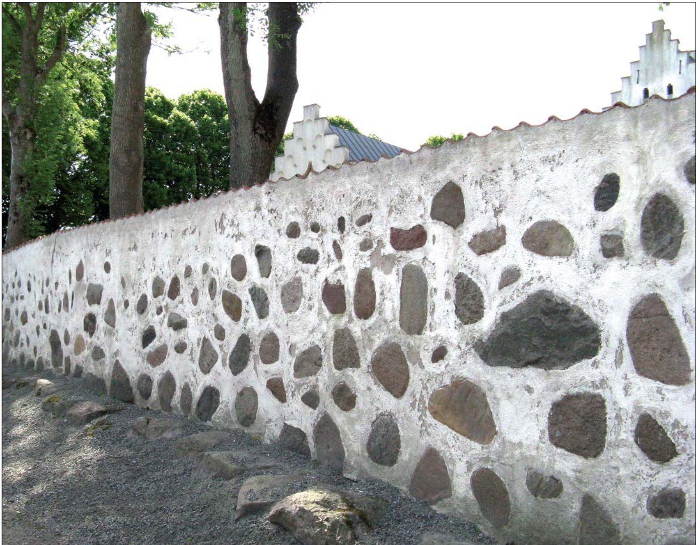
Fogad kallmur av fältsten, avtäckt med tegelpannor. Denna mäktiga mur har fogats för att förhindra att vatten, löv med mera letar sig in i muren. Bruket gör muren tät och skyddar mot väder och vind. Stabiliteten beror på hur väl stenarna är lagda i muren. Foto: Ann-Britt Sörensen
