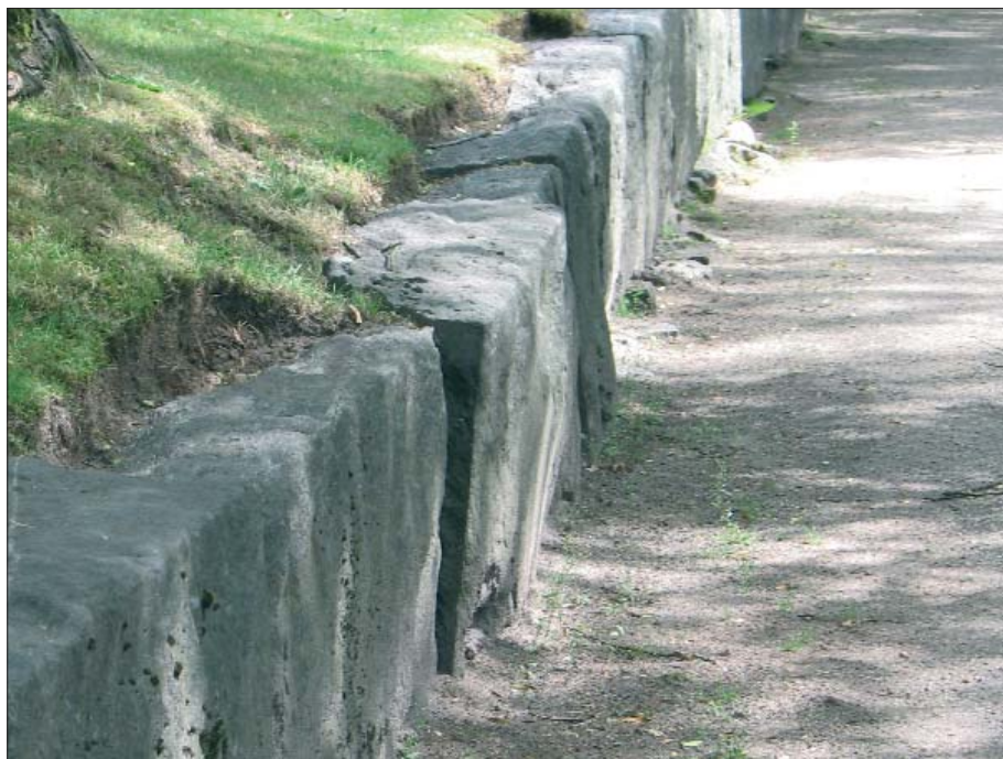
Blockstensmur som fungerar som stödmur. Ett träd som växer uppe på terrassen skjuter med sina rötter stenen ur läge. Foto: Catharina Svala
