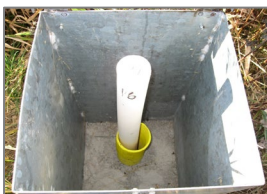
Figur 5. Grundvattenrör. Foto: Maria Blomberg
