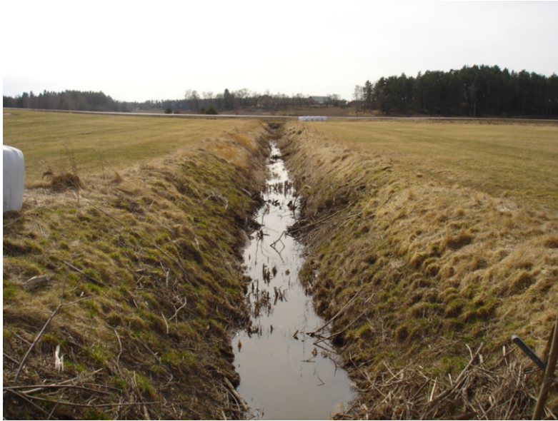
Fotot visar ett dike under våren när friktionen (motståndet) är lägre vilket medför en lägre vattennivå för ett givet flöde. Foto C-J Rangsjö.
