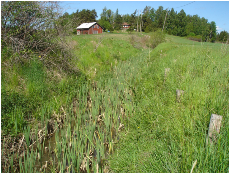
Fotot visar hur friktionen (motståndet) i diket ökar sommartid på grund av växtlighet, vilket kan orsakar höga vattennivåer. Foto C-J Rangsjö.
