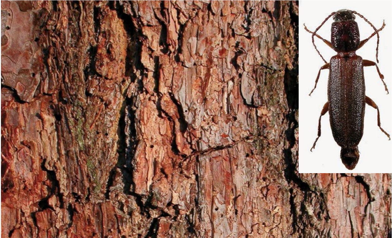
Figur 67. Reliktbocken, Nothorina punctata , gnager gångar i barken och in mot veden på tallar i riktigt varmt och soligt läge. Tallstammen färgas gul av utsipprande kåda. Om miljön blir för skuggig och kall försvinner reliktboken, men hål och gångar i barken finns kvar så länge trädet lever och vittnar om de tidigare ljusare tiderna. Gräsö, Uppland. Foto Tommy Lennartsson.
