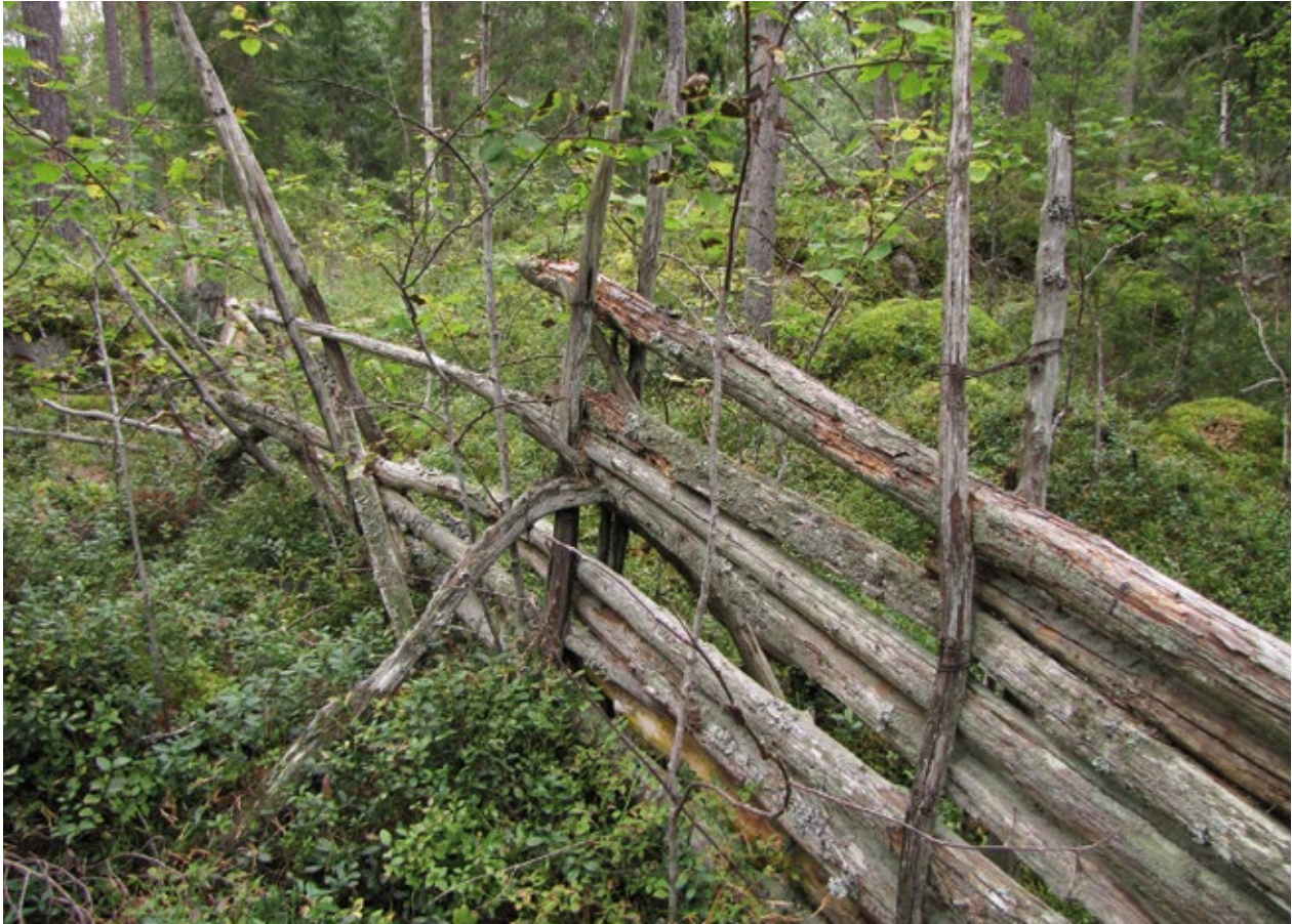
Figur 174. Gärdsgård i ett Uppländskt skogsbete, i en fastighetsgräns tillkommen vid laga skiftet 1859 och underhållen in på 1960-talet. Gärdsgården är nio stänger hög, av okluven gran, rest med enestörrar och bunden med ståltråd. Boda, Börstils socken. Foto Tommy Lennartsson.
