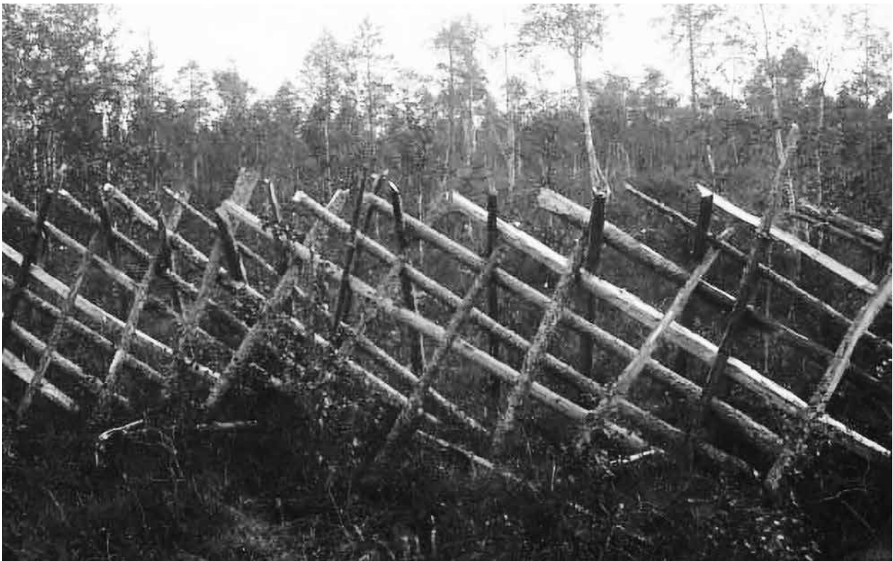
Figur 175. Två slags självstagande gärdsgårdar kring finska svedjeodlingar. Foto Gösta Grotenfelt 1907. Övre bilden kring en kaski-svedja i Karttula, nedre bilden från Tossavanlahti, Keitelä, båda i Savolax. Museiverket.
