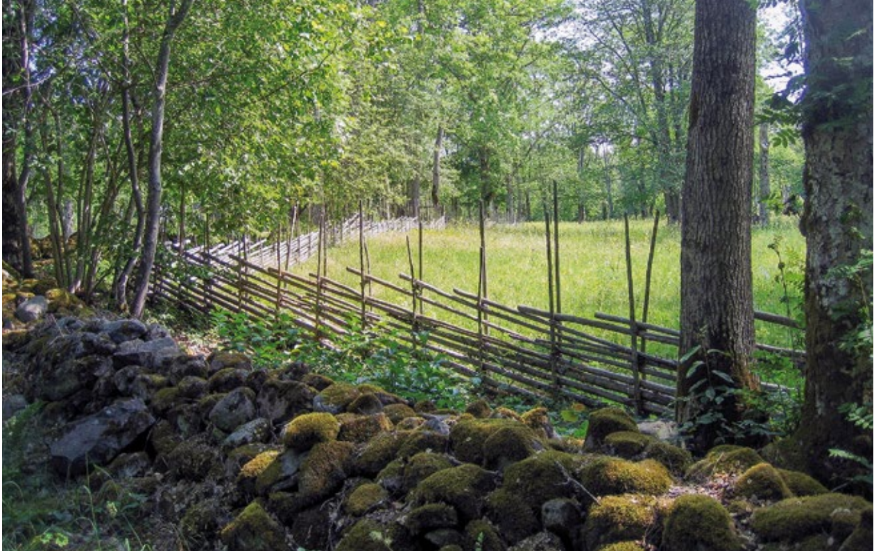
Figur 177. Hankgårdsgård byggd intill den gamla stengårdsgården i Garphyttans nationalpark. Störparen står med jämna avstånd och det liggande gårdselvirket hålls på plats med vidjor som snotts runt störparen som en åtta. Foto Anna Westin.
