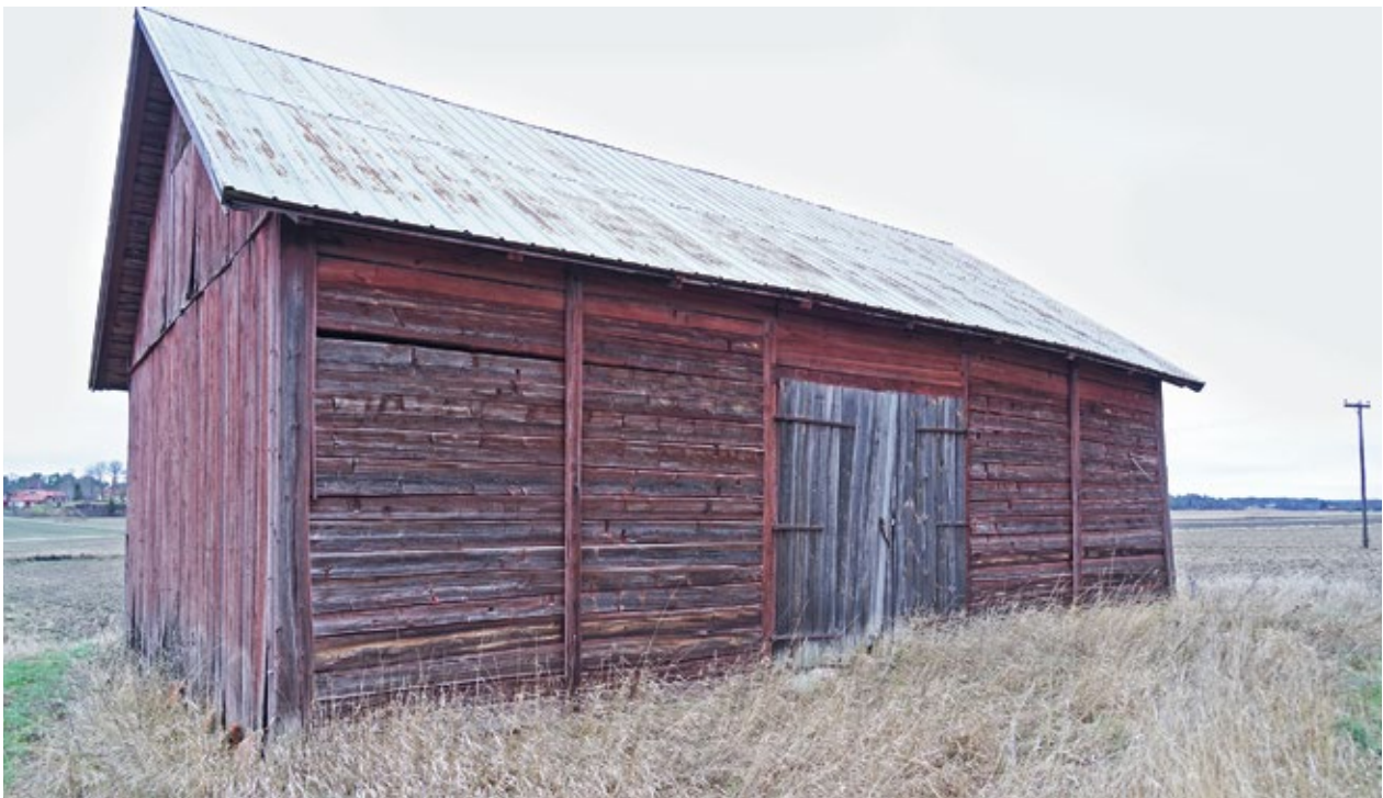
Figur 20. Överst: I ett knuttimrat hus bygger man av liggande fyrkantiga timmerstockar och taket bärs upp av väggarna. Smedstorps dubbelgård, Östergötland. Foto Anna Westin. Nederst: Skiftesverket innebär istället att taket stöttas av stående stolpar. I stolparna finns skårar där man för in plankor eller kort timmer. Avståndet mellan de stående stolparna kan varieras efter längden på det tillgängliga virket. Dalby socken, Uppland. Foto Tommy Lennartsson.
