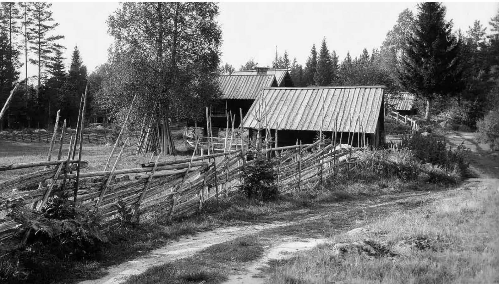
Figur 173. Gårdsgård som lagats nödortfittigt med hjälp av horisontella stänger på toppen. Tekniken har många namn i olika delar av Sverige, överstöra , överpötta , stångdra m.m (Kardell Ö 2004, s. 158). Slättans fäbod, Valbo, Gästrikland. Foto Märten Sjöbeck 1937–38, Gävleborgs Museum.
