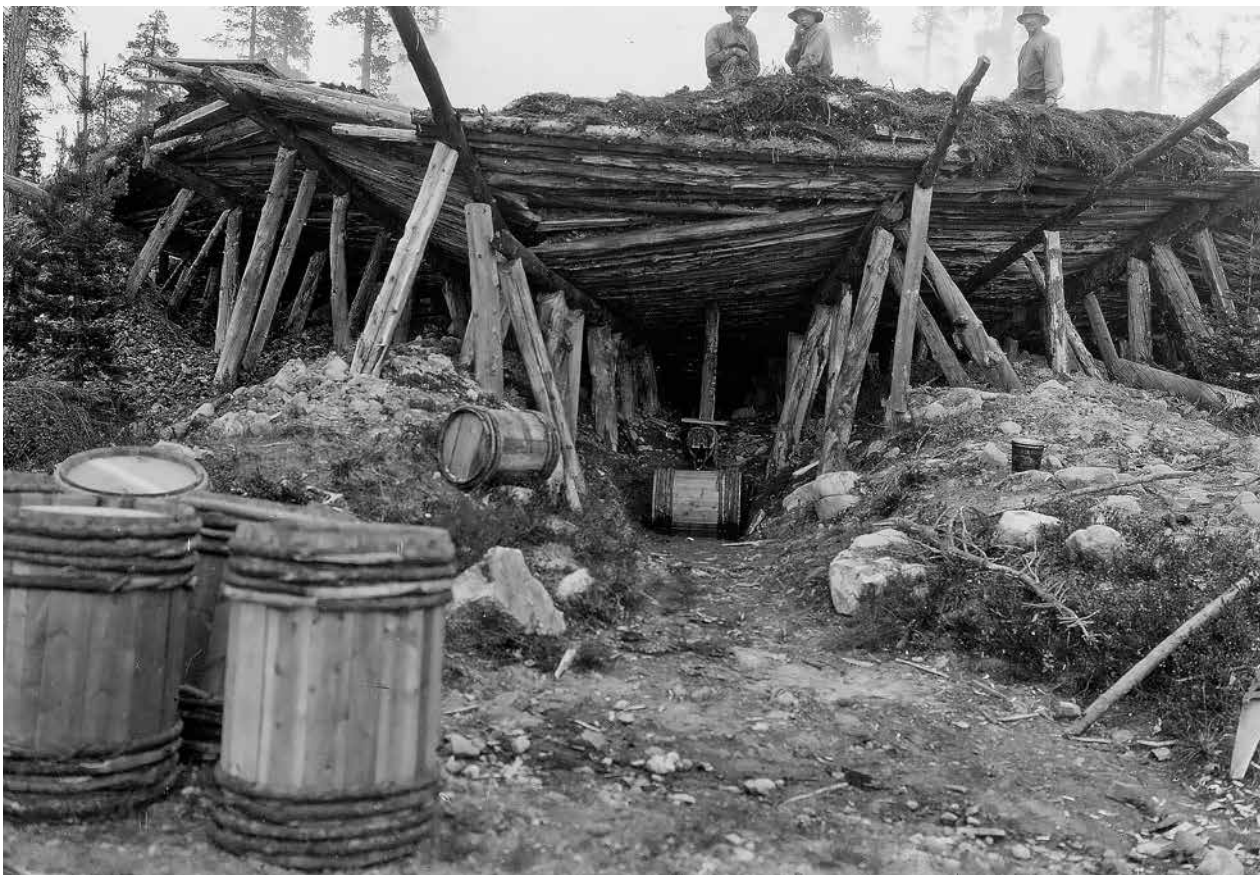
Figur 181. Överst tjärdal under täckning, underst tjärdalen med tunnör redo. Arvidsjaur, Lappland 1924. SLU Historiska skogsbilder.
