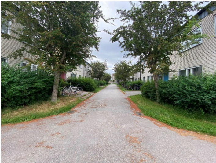
Foto 3. Studentbostäder byggda 1965 kring Våktargatan, Centrala Kapellgärdet
