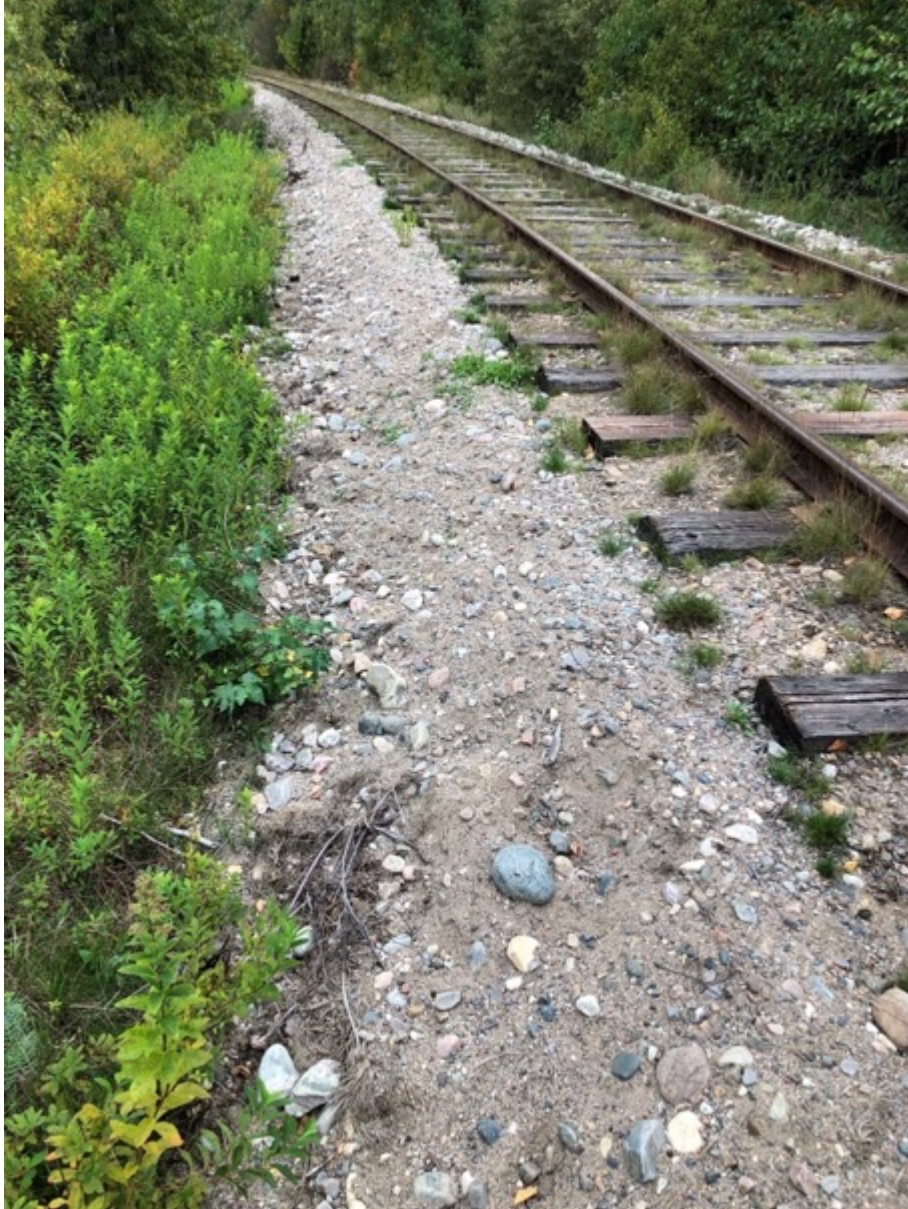
Figur 15. Ballastplogningens resultat efter två körningar i vardera riktningen i NBVJ:s spår från Nora mot Ervalla sommaren 2020.
