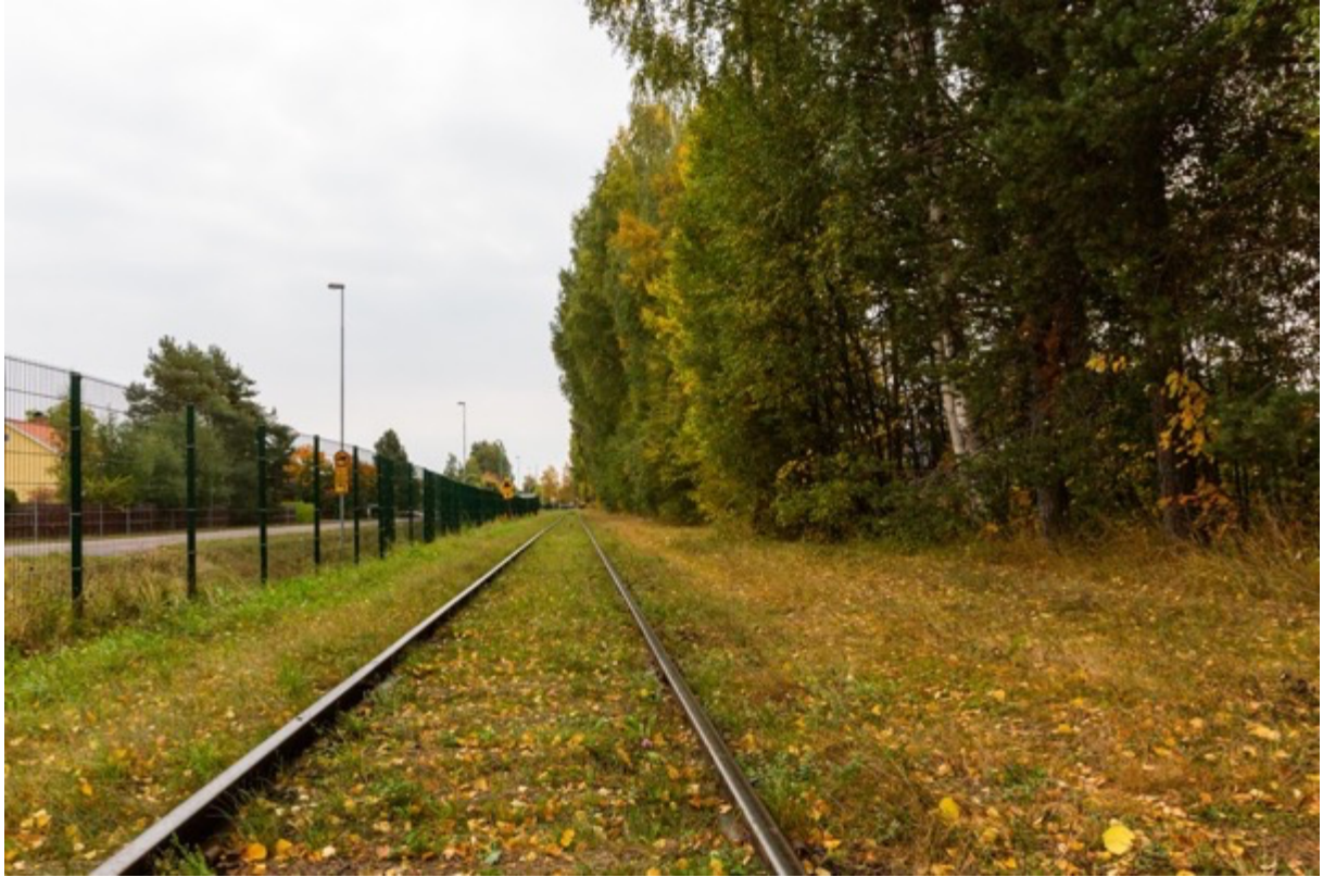
Figur 28. Försökssträckan vid Moraparken. Vegetationen domineras av gräs.
