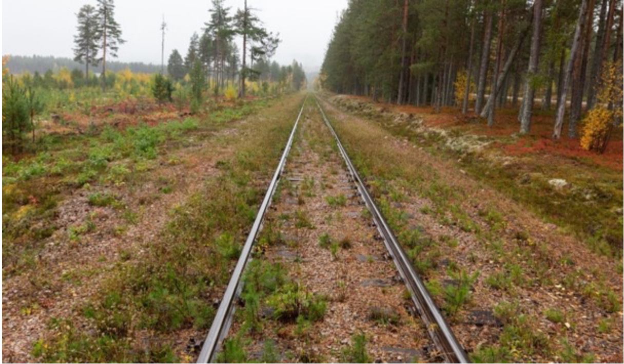
Figur 26. Oxberg – norra änden av försökssträckan med vy mot Mora. Notera det kraftiga inslaget av tallplantor.
