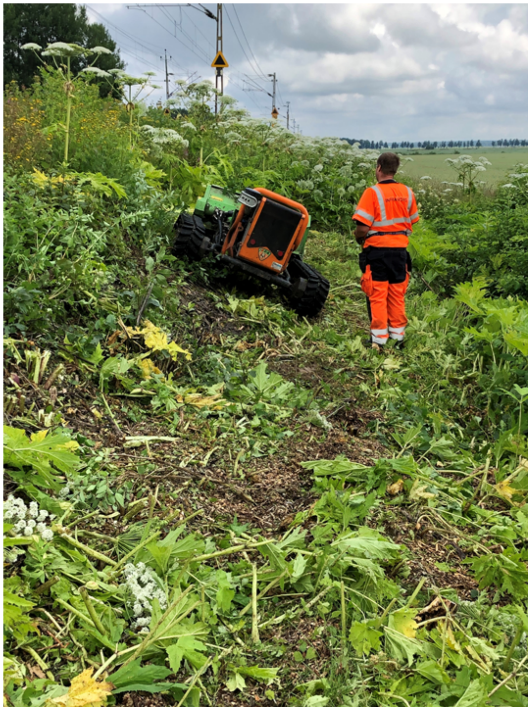
Figur 58. Nedfräsning av jätteloka sommaren 2021.
