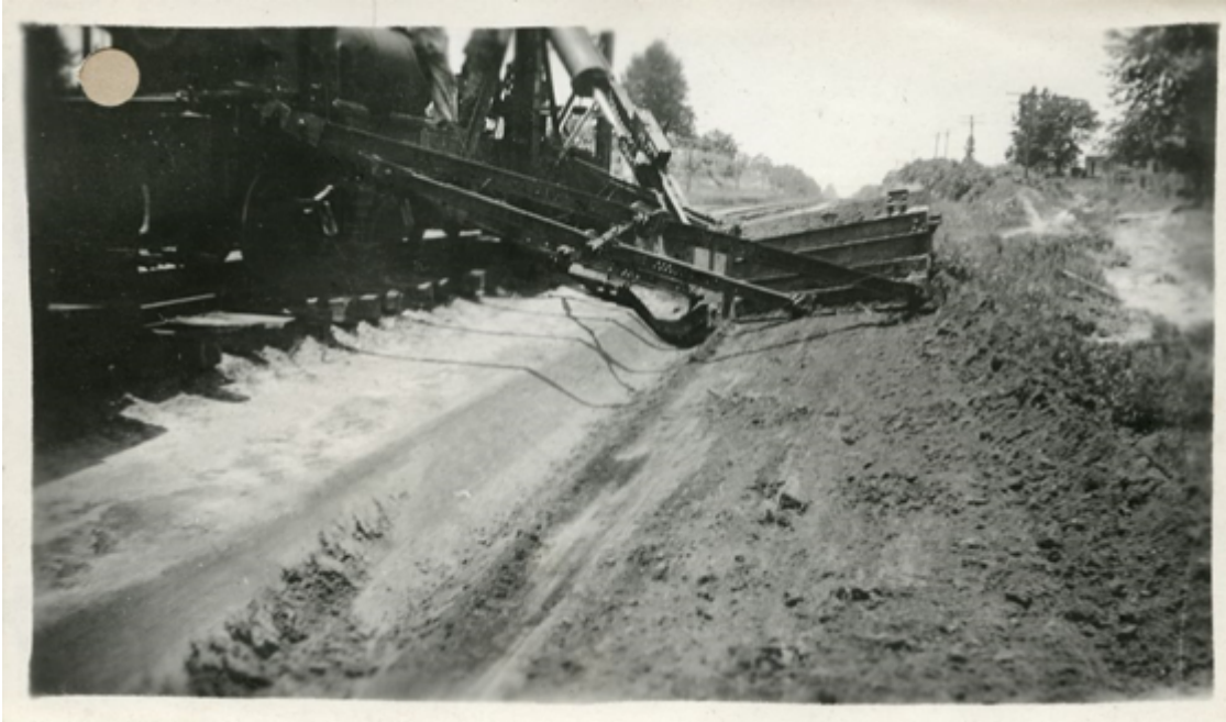
Figur 3. Mekanisk rensning av dike och banvall troligen i perioden 1930–1950. Bild från Samlingsportalen ur Järnvägsmuseets bildarkiv.
