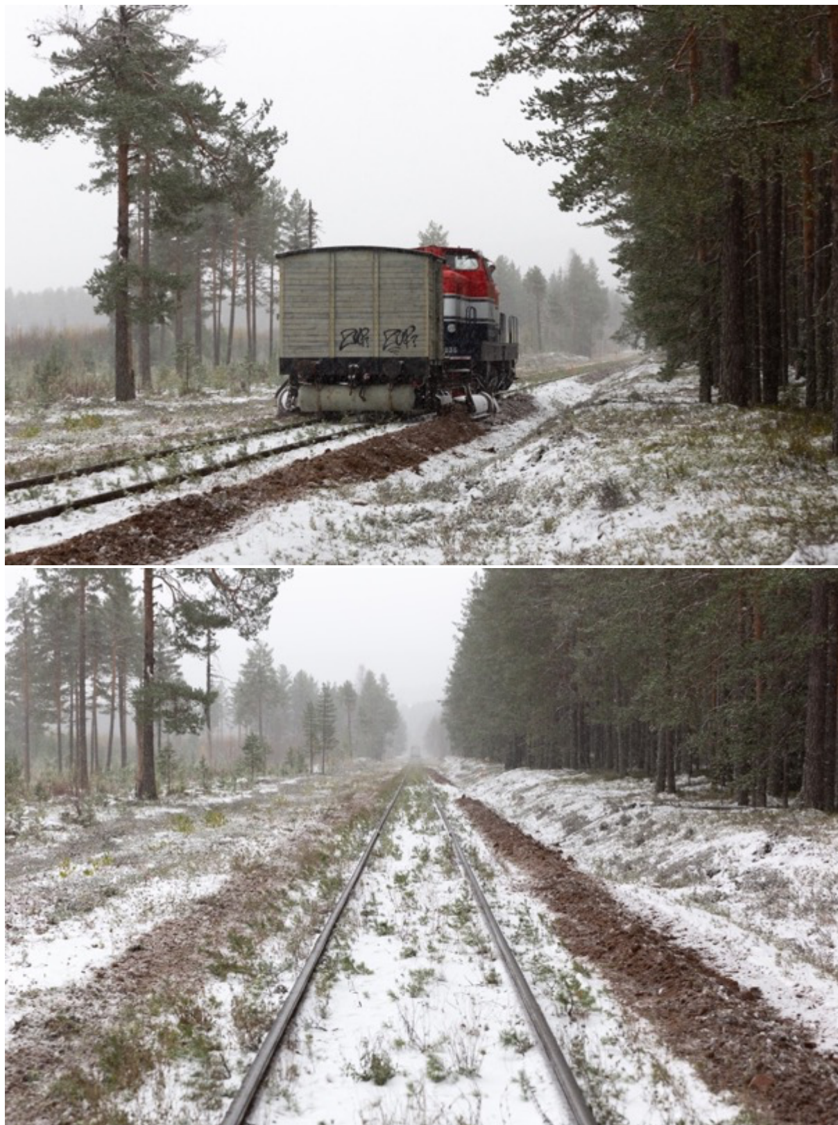
Figur 29. Ojämn effekt av ballastplogen i Oxberg, en effekt av slitna plogar.
