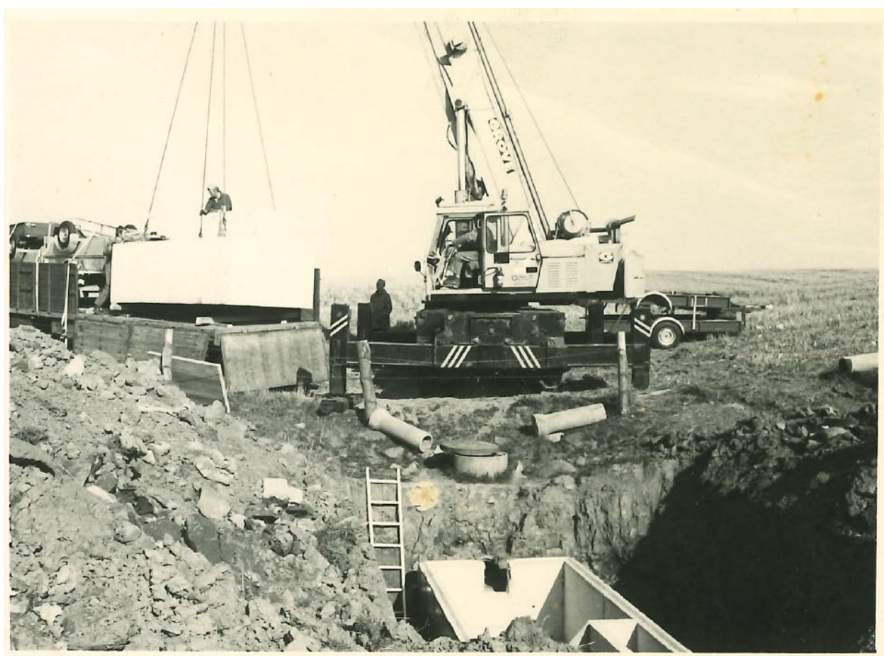
Figur 11. Grävarbete och anläggning av mätstationen för fält 11M, troligen 1975. Fotograf och datum okänt.
