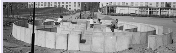
7. En irrgångslabyrint av Oscar Reutersvärd vid Tunaskolan i Lund. Den har en siktlinje genom hela labyrinten för att små barn som inte ser över de högre väggarna ska känna sig trygga genom att då och då få kontakt med vuxna utanför labyrinten genom siktlinjen. Labyrinten byggdes 1968 men revs redan 1972 på grund av materialfel. En häcklabyrint med snarlik planform byggdes 1996 i Stadsparken i Lund och den finns kvar. Foto: Från Lunds universitetsbiblioteks bildsamlingar. Hagblom-foto.
