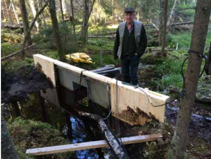
Lars Lundin vid den renoverade damväggen vid avrinningsutskovet, 2015. Foto Göran Gullberg.
