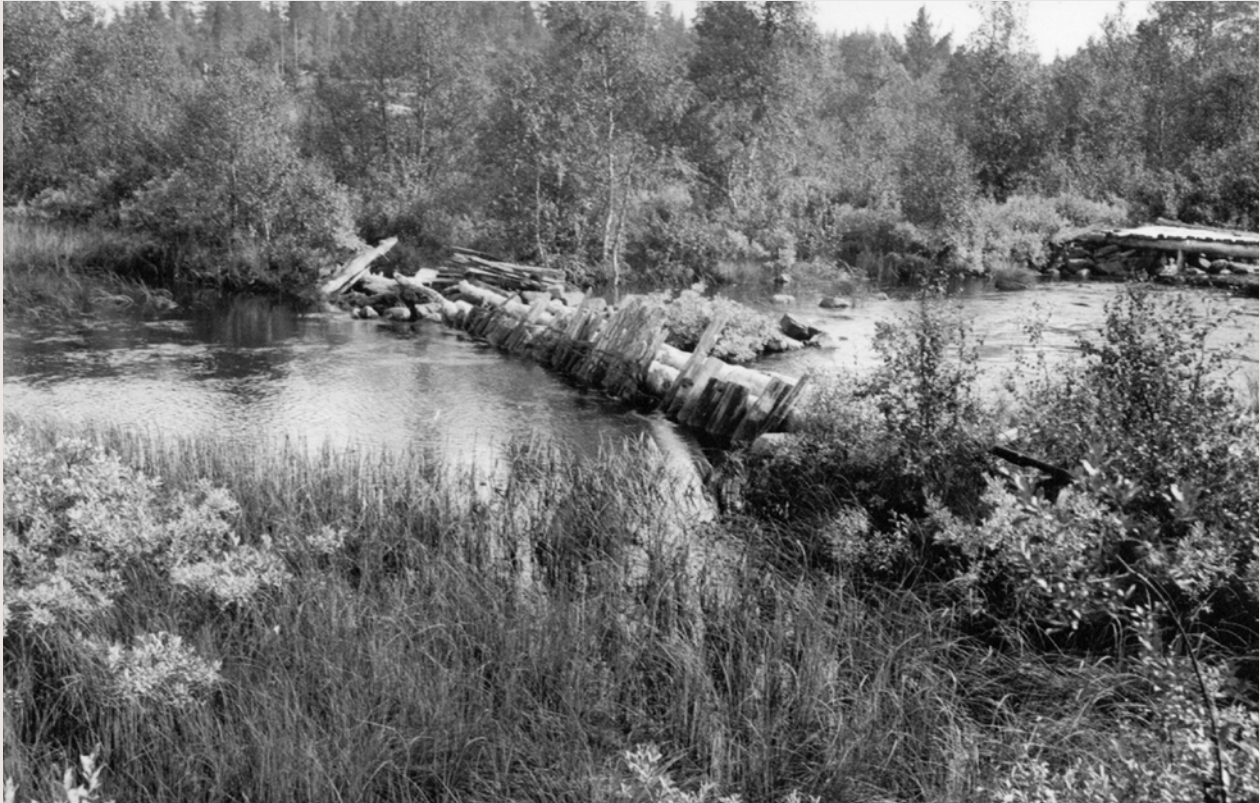
Figur 35. En av de tre dammarna i Grundöjan vid Grundåns nybygge. Här ses de lodräta klovorna snett nedstuckna mot bottensyllen som skulle få vattnet att stiga. Foto: Niss Hjalmar Matsson 1940. Malung-Sälens kommunarkiv.
