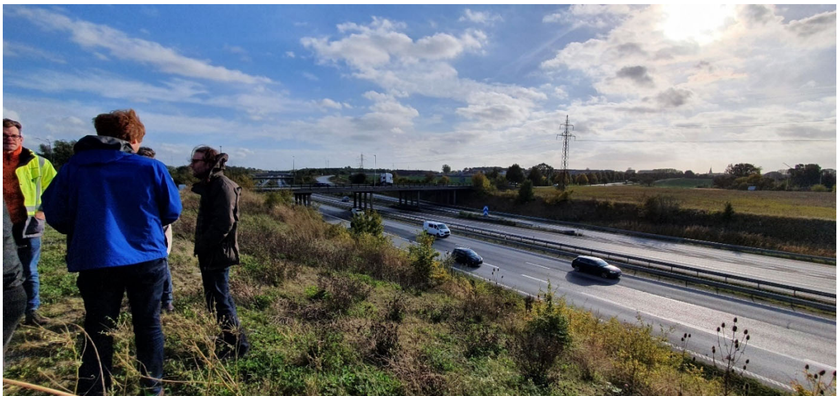
Fig 20. Den terrasserade bullerkyddsvallen mellan Sockervägen och E6 i Burlövs kommun. Översta bilden visar släntfoten och nedersta bilden vallens krön med utsikt mot Burlövs utvecklingsområde på andra sidan motorvägen. Foto från platsbesök 221007 Emily Wade.
