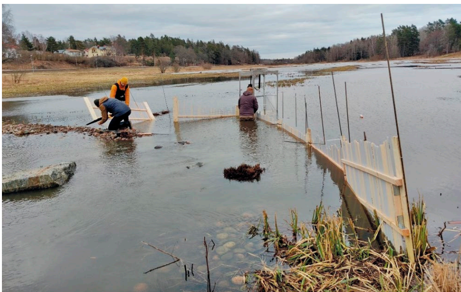
Figur 10. Montering och installation av fiskräknare och ledarmar i Hemmesta sjöäng, Värmdö kommun, 2021-03-17.
