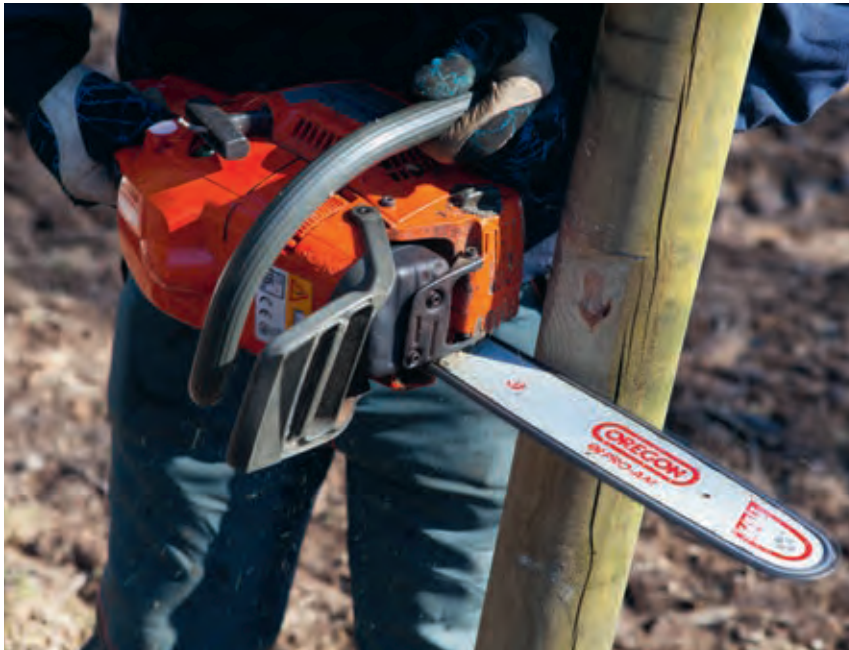
Bild 46. Såga ur lite kring markeringen på stolpen med motorsåg, fogsvans eller yxalkniv. Fäll in överliggaren på platsen. OBS! Montörens vänstertumme ska hållas ner runt motorsågsbågen.
