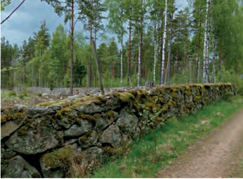
Bild 102. Hög stenvmur kompletterad med fårnät. Observera att nätet behöver kompletteras med eltrådar för att vara rovdjursavvisande.
