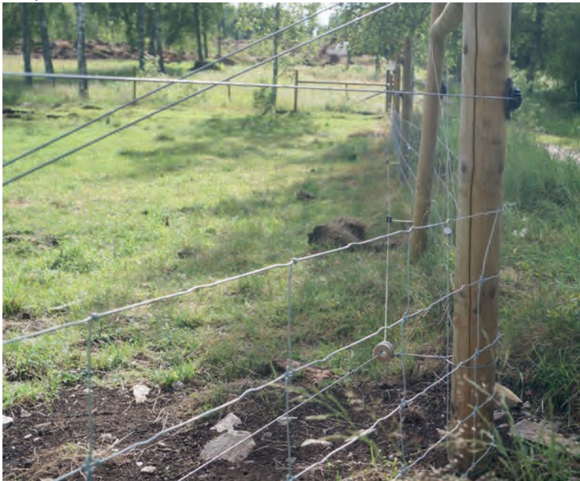
Bild 1. Vålmonterat rovdjursavvisande stängsel bestående av nät Tornado Titan 5-53-30 med två eltrådar ovanför och en låg eltråd på insidan.
