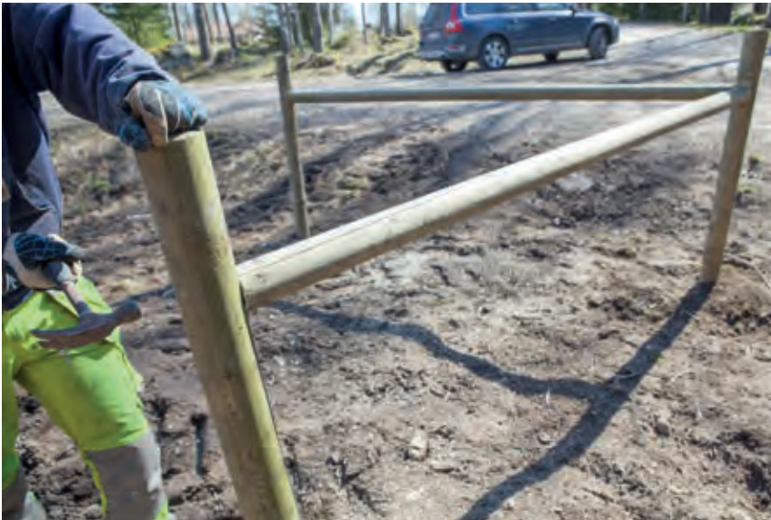
Bild 53. Fäst märklan på utsidan av stolpen som är utåt linjen, mitt för överliggaren.
