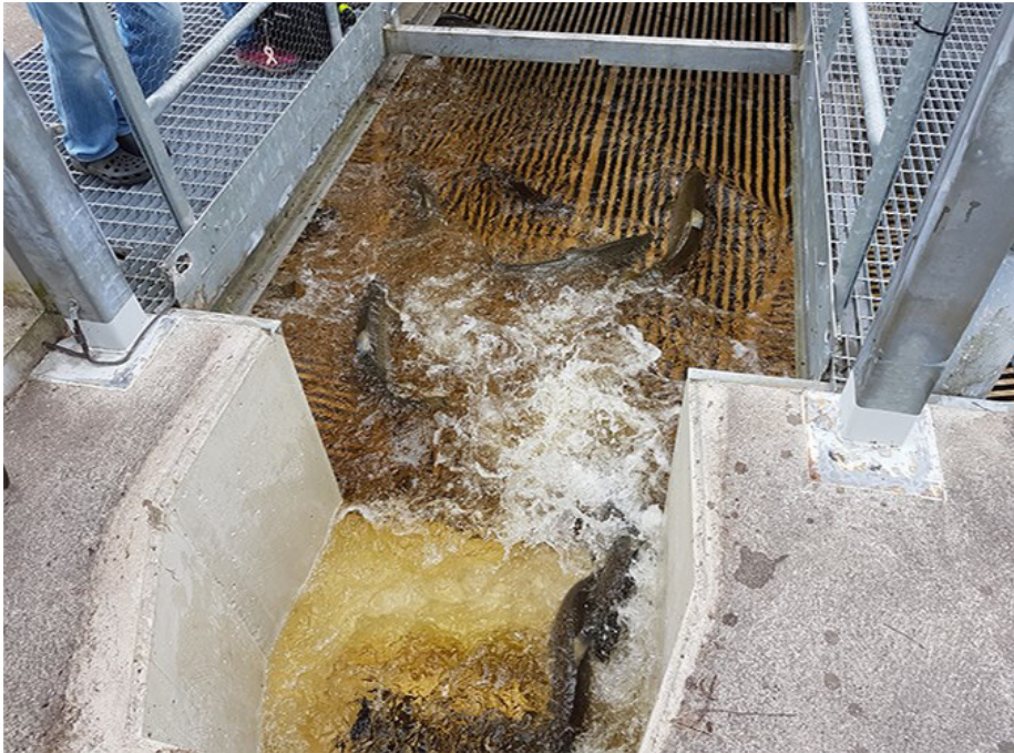
Figur 3. Lax och havsöring fångas i centralfisket i Älvkarleby. Fällan utgörs av en fisktrappa i Kungsådran som leder in till en fångstbur där golvet kan hissas upp och fisken lockas sedan med hjälp av strömmande vatten att simma in i ett rör, nederst i bilden, varefter de hamnar i en bassäng i den så kallade terminalen.
