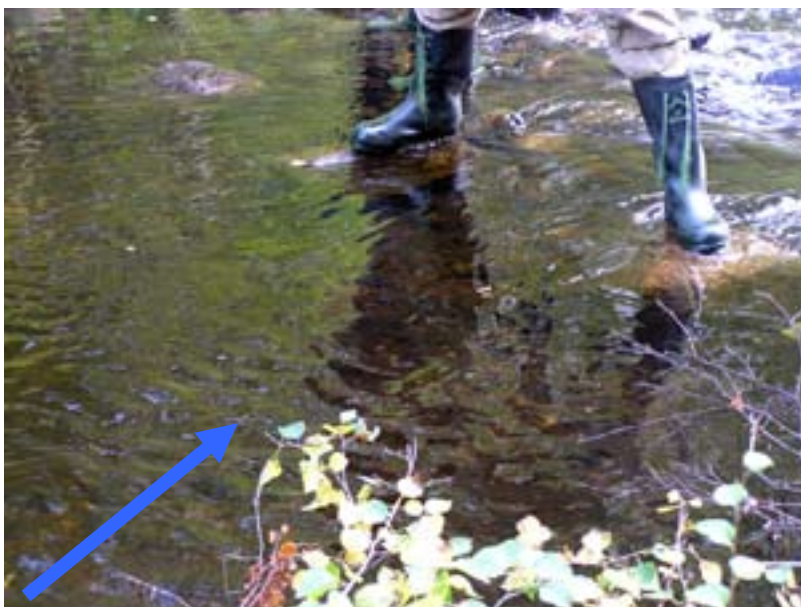
Figur 4. Lekbotten färdigställd. Personen står på de större stenarna som lagts nedströms för att kvarhålla leksubstratet. Dessa stenar läggs i en gles hästskoform nedströms och utmed sidorna. Ibland kan man behöva styra in vatten över lekbotten med hjälp av större sten uppströms. Se till att lekbotten inte ligger så högt att den kan bottenfrysas vintertid.
