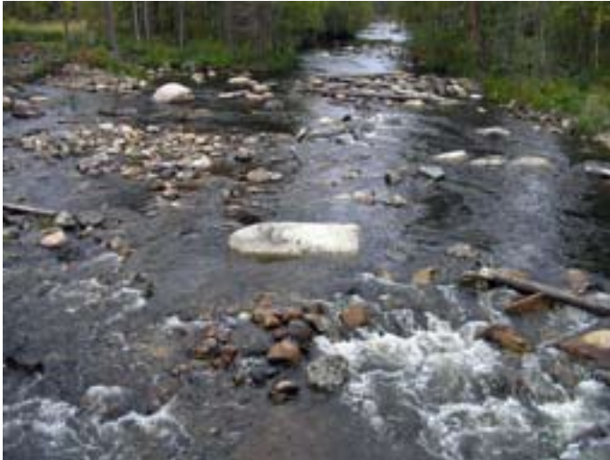
Figur 15. Den restaurerade Ruskträskbäcken, biflöde till Vindelälven, Västerbotten. Eftersträva det slumpmässiga mönstret i naturliga vattendrag, men förstärk de ursprungliga strukturerna där de kan anas; forsnackar, trösklar, höljor och ett meandrande lopp inom vattenfåran (jämför Figur 5).
