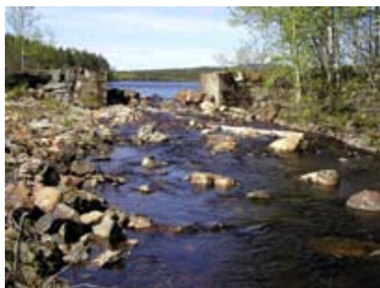
Figur 7. Utløpsdämme vid Storsjön; Strömbäcken i Lögdeälven. Den tidigare flötningsdammens dammtröskel, skibord och sättare har tagits bort (vänster bild). Istället har en naturlig stentröskel etablerats (höger bild). Man kan lämna ännu kvar mer av de tidigare dammstrukturerna utan att påverka. Observera dock att fundamenten innebär att sjöns däm vid höglöden. Plats: 708670-163790, karta 20 I NO. Foto Roger Vallin, Länsstyrelsen i Västerbotten.
