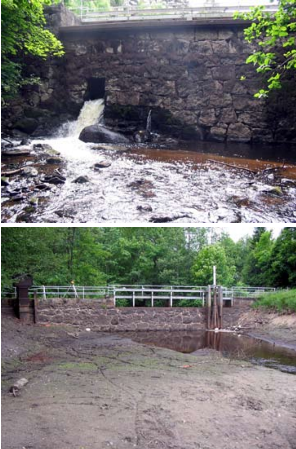
Figur 2. Hökhultsdammen i Tabergsån, Jönköpings län, före utrivning. Dammen var 5 m hög och 350 m lång. Den tömdes försiktigt så att inte sedimentet rubbades. Sedimentet var förorenat och den bästa lösningen var att låta det ligga kvar, men täckas över. Plats: 640033-139960, karta 7 D SO. Foto: Per Sjöstrand, Jönköpings fiskeribiologi.
