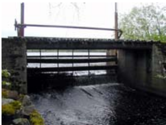
Figur 7. Utløpsdämme vid Storsjön; Strömbäcken i Lögdeälven. Den tidigare flötningsdammens dammtröskel, skibord och sättare har tagits bort (vänster bild). Istället har en naturlig stentröskel etablerats (höger bild). Man kan lämna ännu kvar mer av de tidigare dammstrukturerna utan att påverka. Observera dock att fundamenten innebär att sjöns däm vid höglöden. Plats: 708670-163790, karta 20 I NO. Foto Roger Vallin, Länsstyrelsen i Västerbotten.
