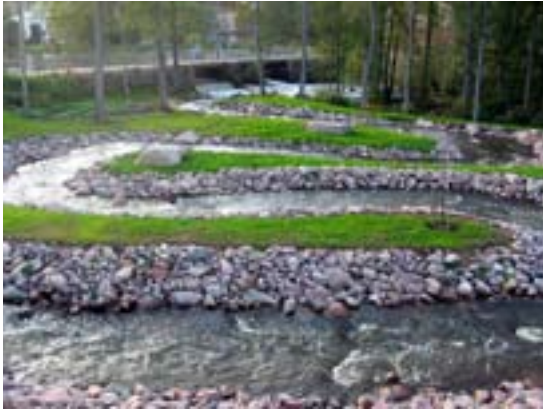
Figur 9. Omlöp vid Åsvallehult i Svartån, Tranås kommun, byggt 2006. Omlöpet är 100 m med en lutning på 2 %. Överst finns ett prefabricerat utskov (från Skanska Prefab AB). Foto & konstruktör: Per Sjöstrand, Jönköpings fiskeribiologi. Plats: 643321-145018, karta 7 F NV.
