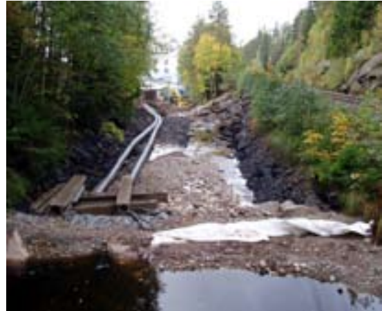
Figur 9. Vatten leds förbi arbetsplatsen genom enkla plaströr från ett dämme ovanför. Foto: Andreas Bäckstrand.
