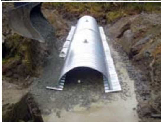
Figur 6. Här har underlaget (stenkross) under vägtrumman kommit på plats i Skärjån uppströms Lill-Tönnebrojärnen. Genom avvägning ser man att det blir rätt lutning (övre bild). Halvtrumman på plats (nedre bild), observera att stödplåtar används istället för gjutna fundament. Plats: 677204-156367, karta 14 H NV. Foto: Peter Hallgren, Söderhamns kommun.
