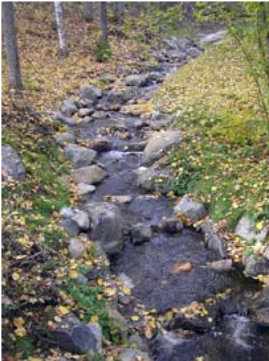
Figur 10. Omlöp förbi stendammen i Sunnäsbruk, Tvärån i Söderhamns kommun. Byggt år 2005. Dammen är en rest av ett gammalt järnbruk och har stort kulturellt värde, varför den bevarades orörd. Vy uppströms. I bildens nederdel syns övre delen av vägtrumma för passage under en bilväg. Lutningen är hela 5 % men de flesta arter bedöms kunna vandra. Konstruktör: Peter Hallgren. Plats: 677750-157030, karta 14 H NV.
