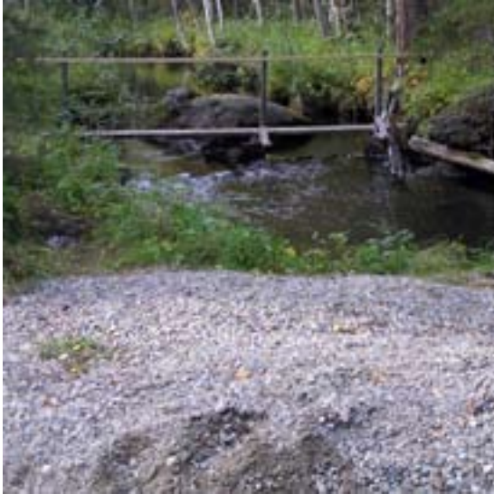
Figur 6. Lekgrus framkört med dumper färdig att läggas ut i Tuggenbäcken, Västerbotten, för hand. Lekgruset lades nedströms den stora stenen mitt i vattendraget (se Figur 7) och kommer därför att ligga kvar vid höglöden (jämför Figur 7 avsnitt 5.9). Genom viss styrning av vattenströmmen med stenar (se Figur 7) erhålls tillräcklig vattenhastighet över substratet. I bäcken flyttades flodpärlmussla tillfälligt vid lekgrusutläggning för att ej störas.
