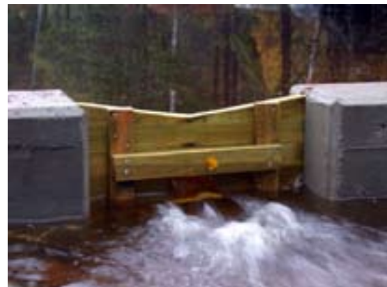
Figur 11. Enkelt flödesutjämmande utskov med underströmningsöppning för fiskpassage vid Boens utlopp i Silverån, Emåns vattensystem (jämför Figur 6). Såväl öring som elritsa har observerats passera. Konstruktör & Foto: Urban Hjalte, Länsstyrelsen i Östergötlands län. Plats 640089-147086, karta 7 F SV.
