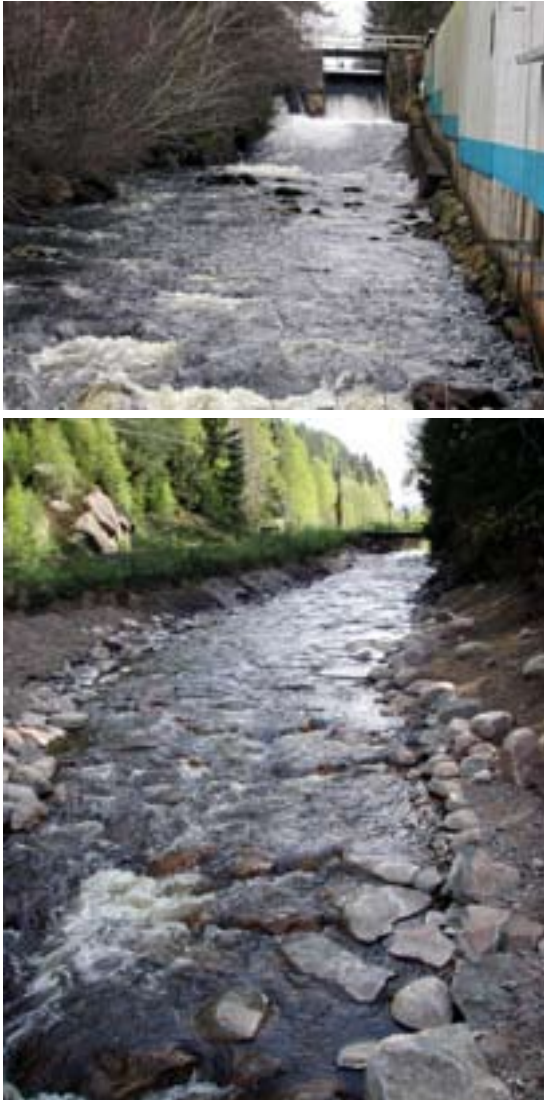
Figur 4. Dammen vid Flyggers färg i Sörån, Grönkullen i Bollebygd, Västra Götalands län, före (övre bild) respektive efter (nedre bild) åtgärd. Det tog 5 år att projektera, förankra, köpa fallrätt och genomföra förbipassage av dammen. Dammen innehöll 3 000 m 3 sediment som visade sig vara förorenat med dioxin. Det gällde således att låta dammen och sedimentet vara kvar. Istället höjde man vattendragets nedströms, s.k. upptröskling (se Avsnitt 5.5) genom att lägga ut 1 000 m 3 sten. Plats: 639870-130873, karta 6 C NV. Foto, övre: Robert Versa, Ignita. Foto, nedre: Andreas Bäckstrand, Länsstyrelsen i Västra Götalands län.
