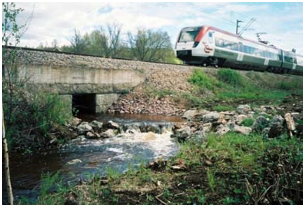
Figur 4. Tröskling nedströms järnvägspassage vid Vikarbyn för att minska vattenhastigheten och få nedströms del att direkt ansluta till trumman utan fall och hopp. Foto: Ove Eriksson, Vägverket.
