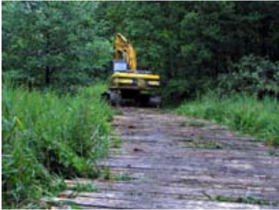
Figur 2. Vid körning på mjuka och våta marker kan det vara nödvändigt att hyra in grävmaskinsmattor för att underlätta framkomligheten och inte få för högt markslitage. Att hyra 100 m mattor kostar ca 5 000 SEK per vecka. Mattorna på bilden är av furu och har dimensionerna 90 × 200 × 4 000 mm.
