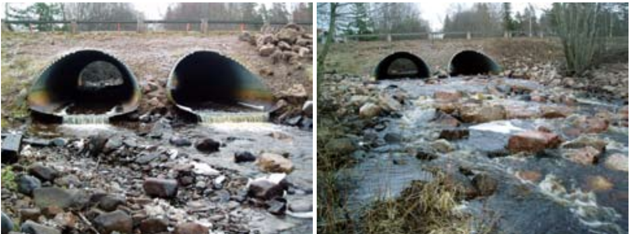
Figur 3. Tröskling nedströms två ovala heltrummor i Enån, Orsa kommun, där ån rinner under riksväg 45. Bild till vänster före, bild till höger efter åtgärd. Trösklarna har ersatts av ett friare och mer naturligt bottenstrukt som fyller samma funktion. Substratet har hämtats på annan plats och lagts på plats med bandgrävare i vattendraget och med handkraft och skottkärra i trummorna. Materialet i trummorna hålls på plats med ett fastsatt rundjärn i trumman nedre del. Plats: 677760-143837, karta 14 E NO. Foto: Anders Bruks, Fiskresursgruppen.
