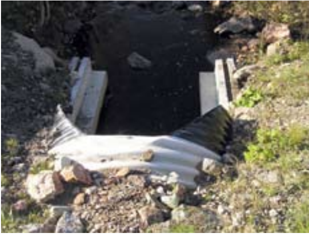
Figur 5. Vy uppifrån över inlopp till halvtrumma på betongfundament. Observera hur fundamenten gjutits med en slits som underlättar inplacering och stabilisering av trumman. Den uppmärksamme läsaren kan ana från vattendragets bredd att trumman tyvärr är något underdimensionerad.
