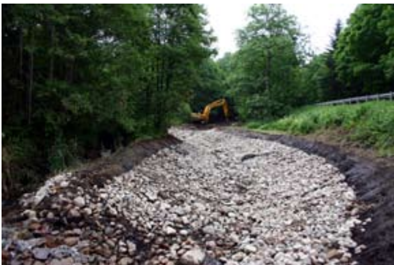
Figur 9. Stensula i Stenån, Himleås vattensystem. Stensulan är uppbyggd av natursten 120–600 mm i ca 0,7 m tjockt lager. Detta gjordes för att stabilisera mjuka sediment inom ett tidigare dammläge. Stensulan lades på stränderna upp till högvattennivån. Plats: 634037-129951, karta 5 B NO. Foto: Lars-Göran Pärklint.
