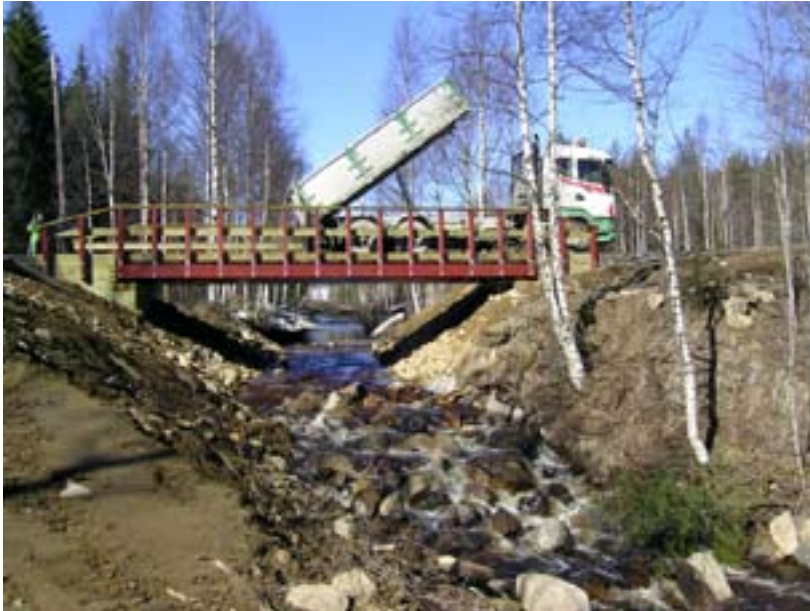
Figur 10. Limträbro över Strömbäcken ett biflöde till Mjösjöån som mynnar i Lögde älv. Bron inklusive alla åtgärder på plats samt utrivning av några skibord och bottenrestaurering av ca 100 m av det berörda vattendraget kostade 500 000 SEK. Plats: 708620-164075, karta 20 I NO . Foto: Stefan Andersson, Länsstyrelsen i Västerbotten.
