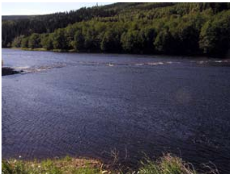
Figur 18. En låg tröskel har lagts tvärs över Klarälven för att höja vattenytan och därmed styra in vatten i den öppnade bifåran i Figur 17. Bifårans inlopp anas till vänster i bild.
