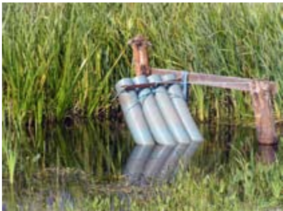
Figur 12. Överfallsbrunn medger en enkel reglering av vattennivån, antingen genom att man successivt byter krage på röret (övre bild) eller genom att röret är flexibelt och kan böjas (nedre bilden). Brunnen kan förses med ett kupolgaller för att förhindra att skräp följer med och fastnar.
