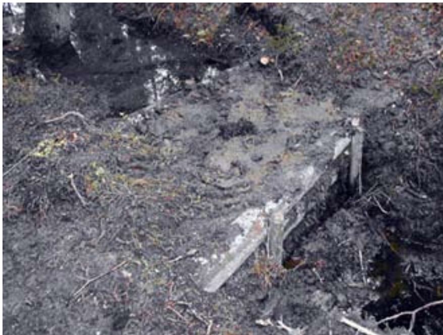
Figur 2. Manuellt byggda dämmen i skogsdiken i Laskerud, Värmland. Foto: Lennart Henrikson, WWF.
