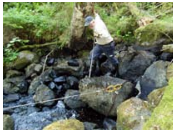
Figur 5. Det går att rubba ganska stora block med spett och taljspel. Här är arbete i Fallängesån (Tvärån) i Söderhamns kommun. Foto: Peter Hallgren, Söderhamns kommun.
