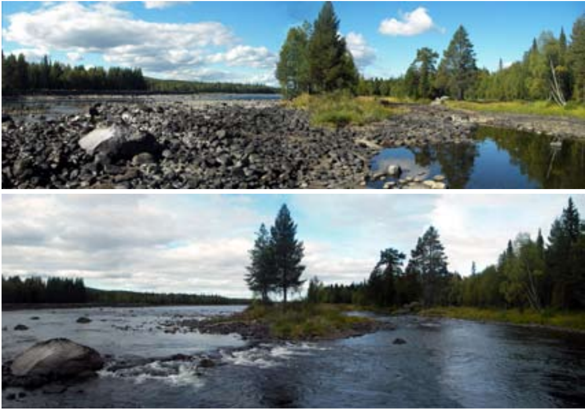
Figur 19. I den flottledsrensade Holmforsen i Vindelälven hade sten lagts utmed stränderna i stenkistor så en stor del av stranden och kvillområden stängts av från älven (övre bild). Genom att öppna upp och fördela stenen tillbaka till vattendraget ökades vattendragets bredd och mångformighet samtidigt som vattenhastigheten dämpades (nedre bild).
