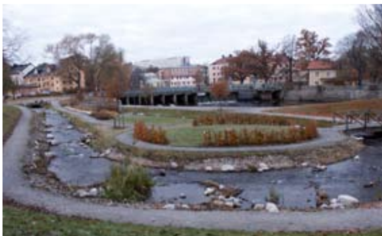
Figur 7. Omlöpet runt Slussen i Svartån i Örebro. Omlöpet är 180 m långt. Ett vilområde är placerat i kröken (närmast i bilden) som är bredare än övriga delar. Omlöpet har en lutning på 1,1 % och vattenhastigheten i omlöpet har mätts till 0,5–0,7 m/s i mitten, men naturligtvis är det lugnare nära botten och bakom de stenar som lagts ut. Bredden är 3,3 m, medeldjupet 0,3 m, med ett maxdjup av 0,65 m. Det har visats fungera för alla arter, t.ex. benlöja, mört, färna, gädda, regnbåge m fl. Utskovet göts på plats under en gångväg och blev därmed dyrt. Konstruktör: Lars Pettersson. Plats: 657263-146762, karta 10 F SV.
