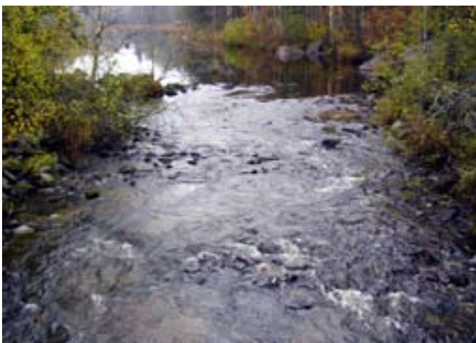
Figur 16. Här har man med grävmaskin (övre bild) grävt en meandrad djupfåra (nedre bild) i ett moränvattendrag, Skårjån, så att det håller vatten och tillåter fiskvandring under lågvattenperioder. Plats: 677162-156692, karta 14 H NV. Foto: Peter Hallgren, Söderhamns kommun
