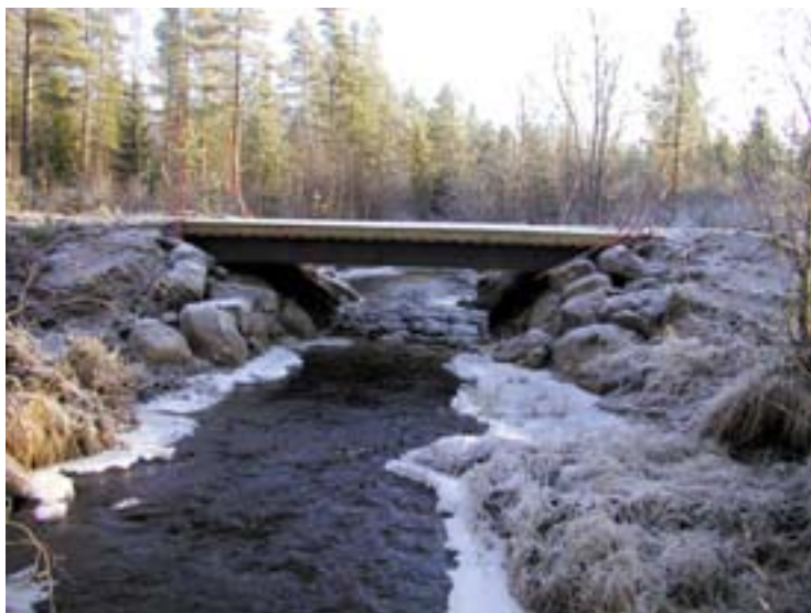
Figur 9. Järnbalksbro med körbana av trä. Bron bärs av sex järnbalkar som vilar på landfundament av betong. Ovanpå järnbalkarna ligger träsyllar med en körbana av fastspikade träplankor. Totalkostnaden för projektet var 65 000 SEK. Bron går över Brännbäcken som är ett biflöde till Sävarån, Västerbotten. Plats: 713168-171283, karta 21 K NV. Foto: Mats Norberg, Länsstyrelsen i Västerbotten.
