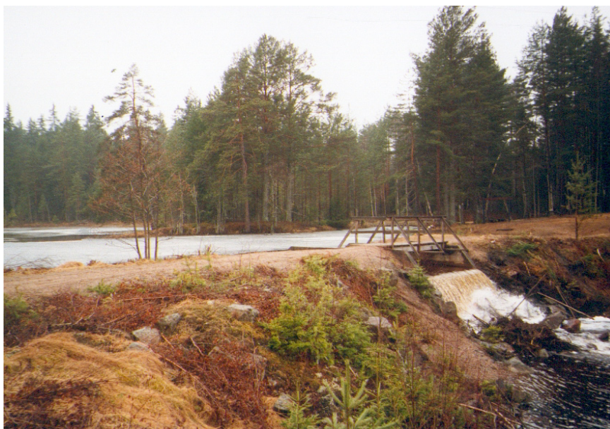
Utlöppet från sedimenteringsbassäng för vatten från Saxberget strax innan vattnet rinner ut i sjön Saxen.
