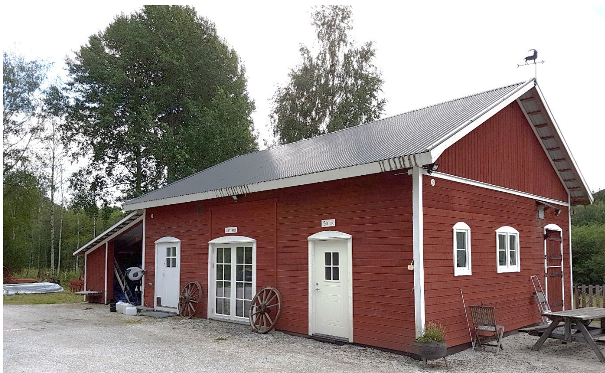
Figur 5.1. Byggnadens form, färg och detaljlösningar är viktiga för helhetsintrycket.
