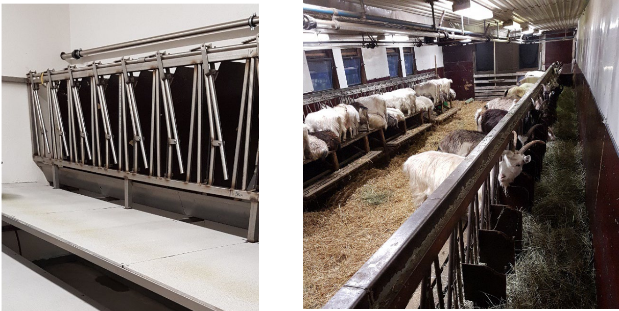
Figur 9.13. Till vänster finns en upphoppningspall som förs under mjölkbordet vid mjölkningen. Till höger är alla getterna fastlåsta vid utfodring och mjölkning. Rörmjölknigen finns under taket. Vid mjölkning fälls upphoppningstrallen upp och mjölkaren går på ströbädden.
