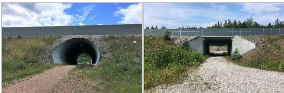
Bild 34. Trumma respektive plattrambro under samma väg; Nolby port och Hemmanet port under fyrfilig motorväg E4 vid Sundsvall. Trumman ligger lägre i vägbanken och skapar längre sträcka under tak, i dessa fall 33 resp. 22 m. Foto Trafikverket.
