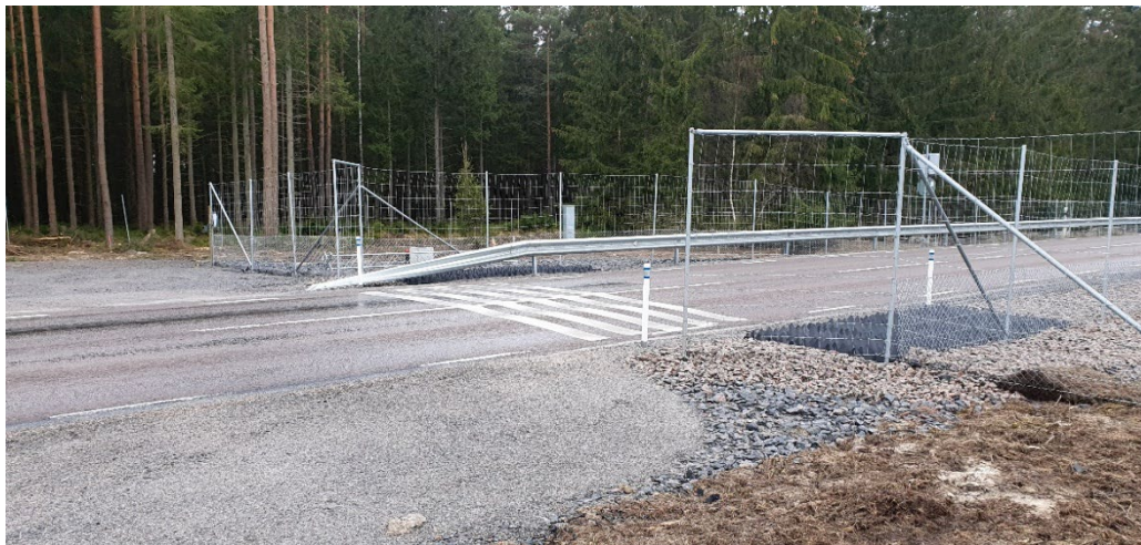
Bild 30. Faunapassage i plan vid Koberg i Västergötland. Här ser man stängselavslut, samt vägmarkeringar och konmattor som ska motverka att djuren tar sig in på det stängslade vägområdet. Foto Marcus Elfström /EnviroPlanning AB.
