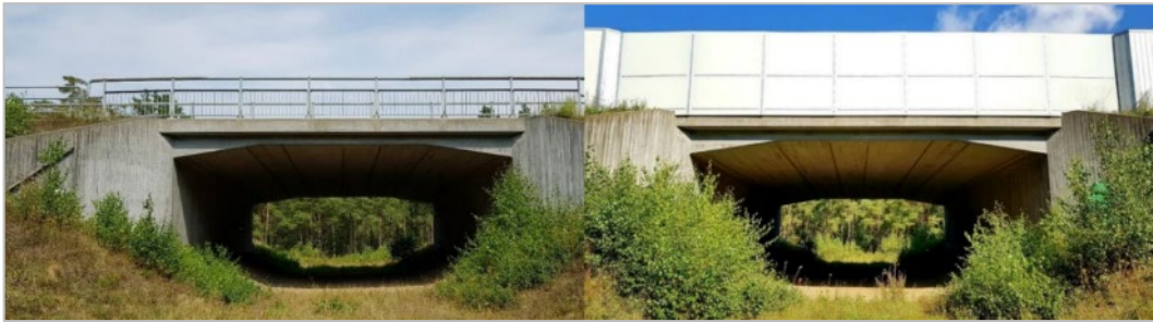
Bild 26. Faunaporten vid Vomb före och efter skärmning. Foto Marcus Elfström /EnviroPlanning AB.
