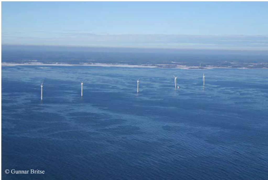
Figur 5. I Egentliga Östersjön har studier av hur havsbaserad vindkraft påverkar fisk genomförts i en tidigare vindpark i Kalmarsund som nu är nedmonterad (Andersson och Öhman 2010). Bildkälla: https://www.windpowerphotos.com/
