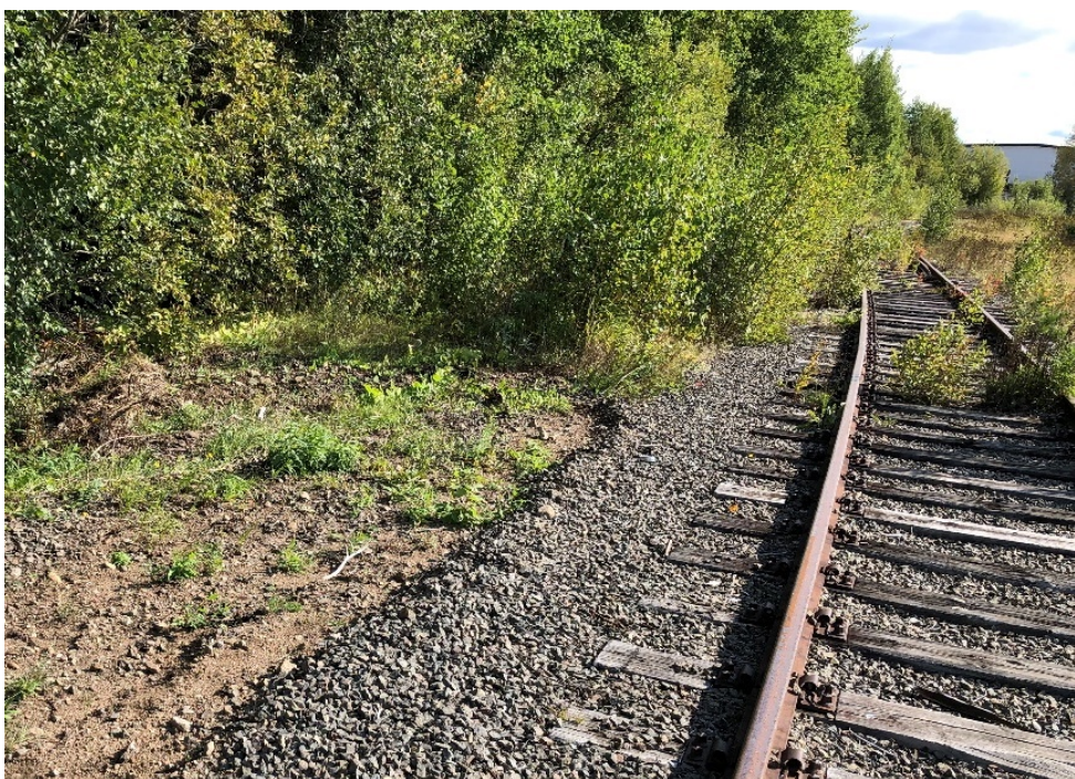
Figur 12. Vansbro. Ytan i förgrunden är rensad på sly med en enkel vägskrapa. Bakom denna yta syns utgångsläget före rensning.
