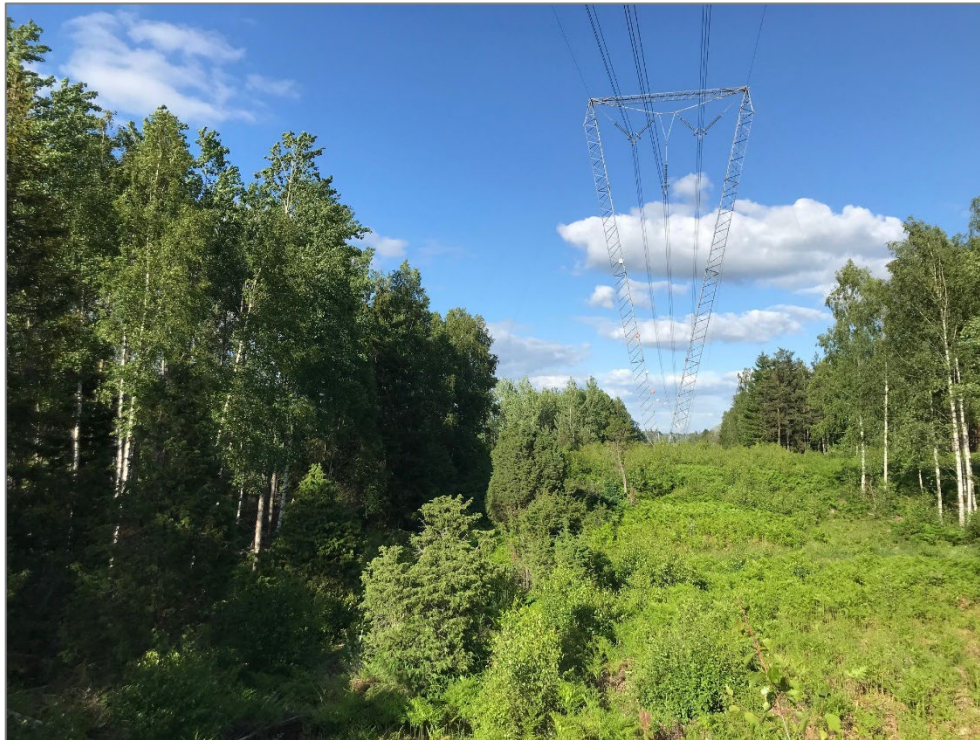
Bild 8. Smalare kraftledningsgata (här ca 20m bred) genom skogsområde nära Hallstahammar. Ledningen har en stolphöjd på ca 40 m. Foto J-O Helldin.
