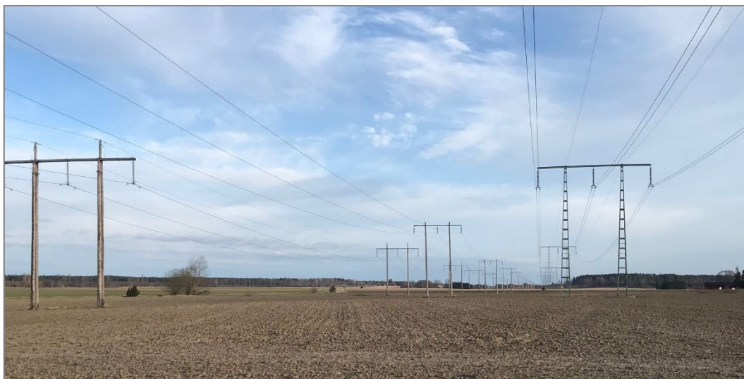
Bild 3. Kraftledningar mellan Västerås och Sala; ledning i regionnätet till vänster, transmissionsnätet till höger och en större ledning inom lokalnätet i mitten. Foto J-O Helldin.
