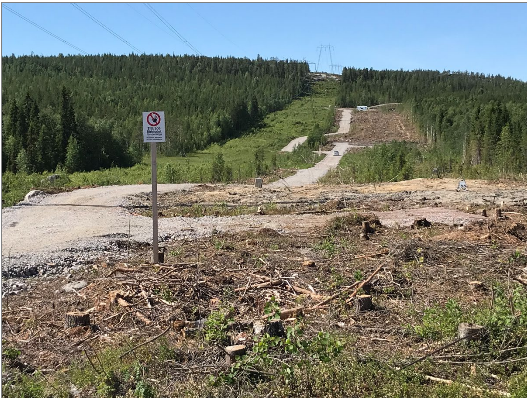
Bild 5. Anläggning av ny transmissionsledning parallellt med befintlig; Aurora line vid Överkalix. Foto J-O Helldin.
