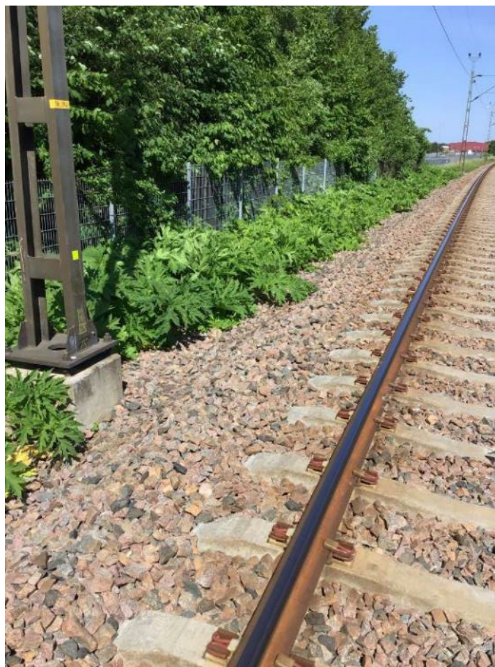
Figur 13. Typiskt exempel på problematiskt jättelokabestånd utmed järnvägen. Makadamiserat, smalt och med självmordstaket och andra hinder i vägen. Ytan är olämplig att fräsas. Foto: Actum Greentech AB.
