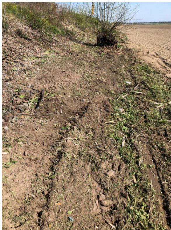
Figur 6. Resultatet omedelbart efter fräsning den 11 maj 2023. Notera att marken här främst är jord vilket gör att fräshuvudet gör en ordentlig bearbetning av marken jämfört med ytor med mycket makadam. Foto: Fredrik Fogelberg.
