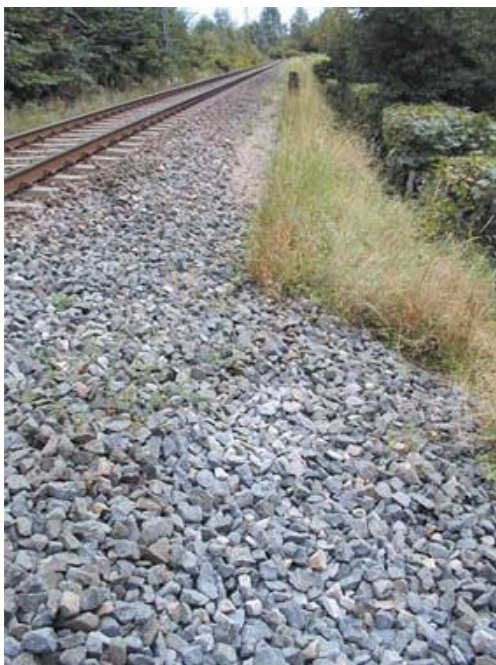
Figur 2. Gräns mellan geotextilen Lotrak 400 och en kort referensyta och därefter obehandlad banvallsslänt som ger en bild av utgångsläget. Från försök i Alvesta.
