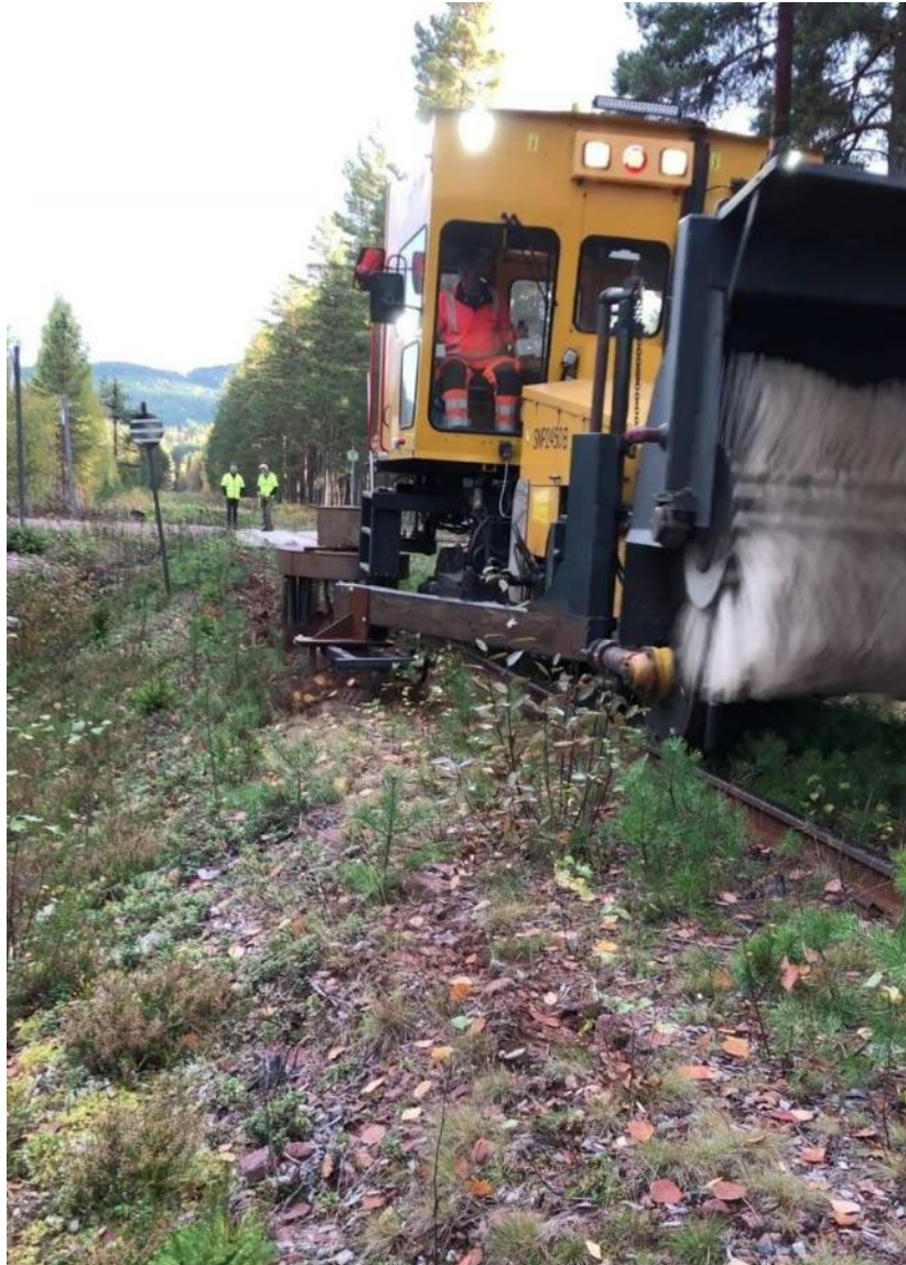
Figur 34. Plog för att samtidigt avlägsna vegetation och skapa dike. Älvdalenbanan hösten 2024. Foto: Fredrik Fogelberg.
