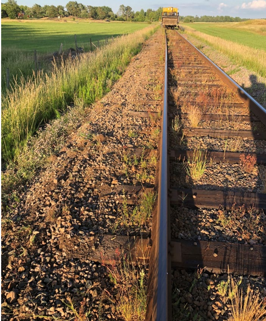
Figur 13. Effekt av skrapning av skuldran med gåsfotsskär omedelbart efter behandling strax utanför Forshem (Kinnekullebanan 2023). Foto: Fredrik Fogelberg.
