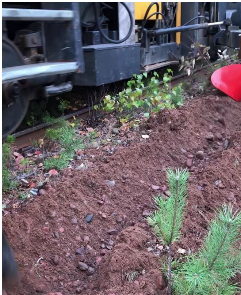
Figur 35 Plogen vänder upp gruset mot sliperkanten och skapar ett ca 30 cm djup dike. Foto ur filmsekvens från prov utfört på Älvdalenbanan 2024. Foto: Fredrik Fogelberg.
