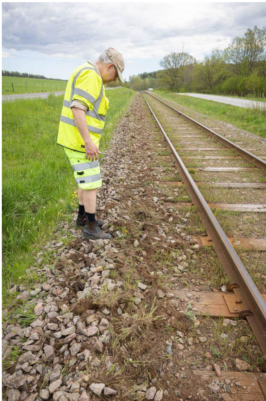
Figur 14. Fredrik inspekterar resultatet omedelbart efter en skrapning med gåsfotskären på Tjustbanan, 2024. Makadam och finmaterial har blandats runt och ogräsen har delvis ryckts upp och deponerats på ytan. Foto: Harald Cederlund.
