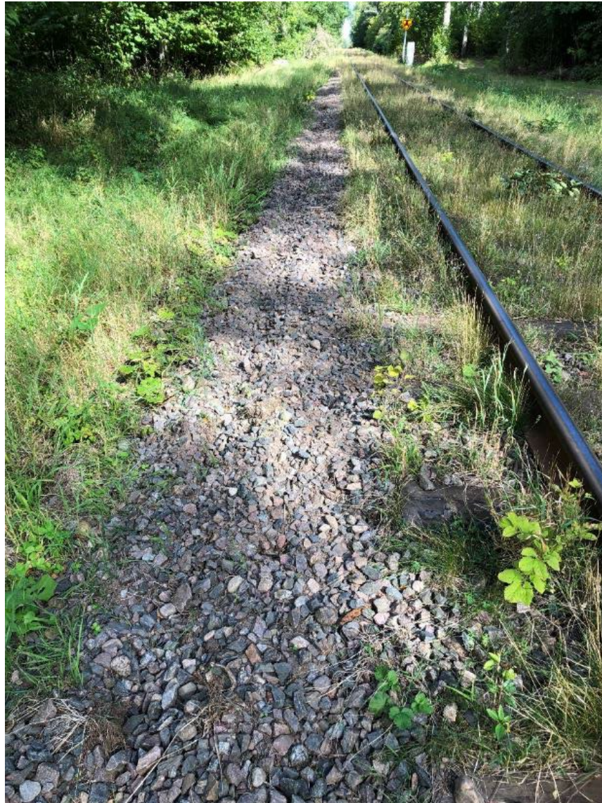
Figur 20.. Effekt efter dubbel skrapning av skrapning vid Trolmens station. Foto taget i början av september 2024, dvs ca en månad efter den andra skrapningen. Foto: Fredrik Fogelberg.
