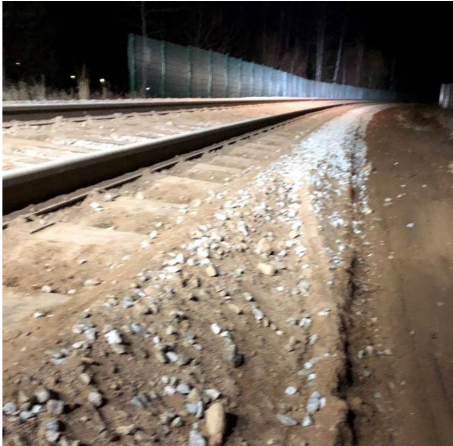
Figur 32. Effekten av skrapning med Infranords ballastplog av modellen Plasser & Theurer, Mariestad 2021. Foto: Fredrik Fogelberg.
