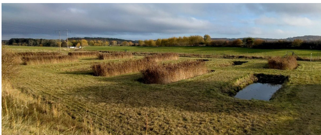
Figur 2. Den experimentella våtmarksanläggningen förberedd inför pilotstudien. Hälften av våtmarkerna var djupa utan vegetation och den andra hälften är grunda med vegetation. Foto: Josefin Nilsson, 2024-10-24.
