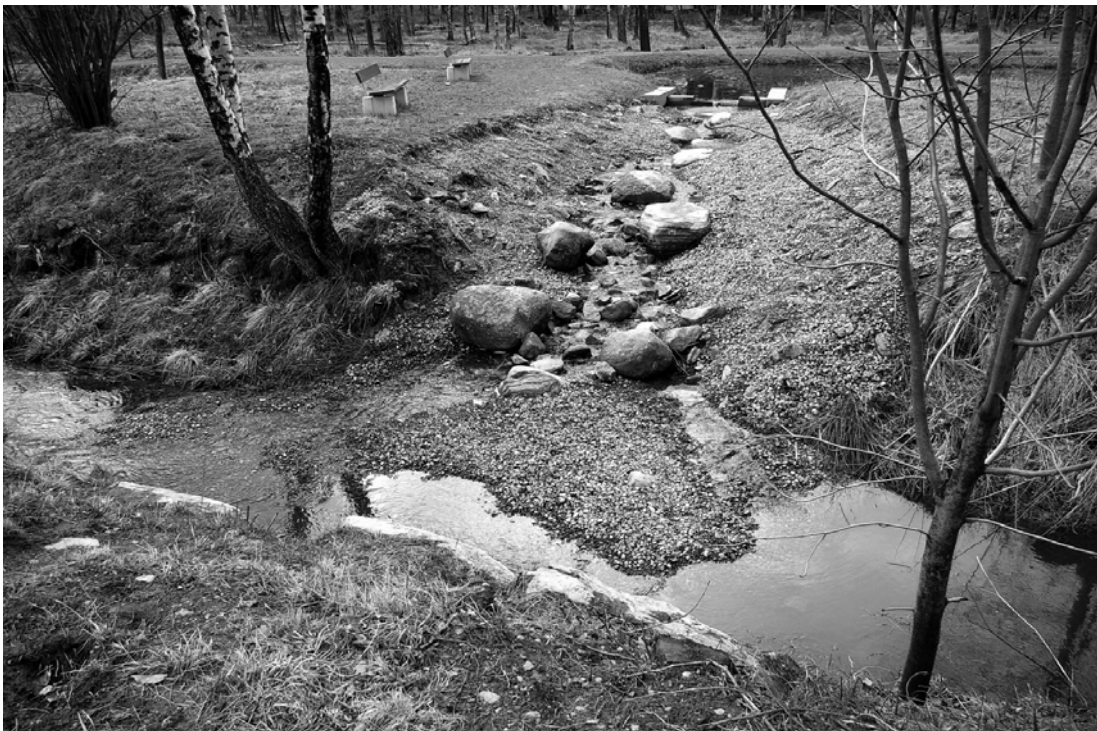
Figur 15. Ett underdimensionerat erosionsskydd i ett utlopp som medfört att en stor del av befintligt erosionsskydd glidit ner i bäcken. Bild tagen av Jesper Persson.
