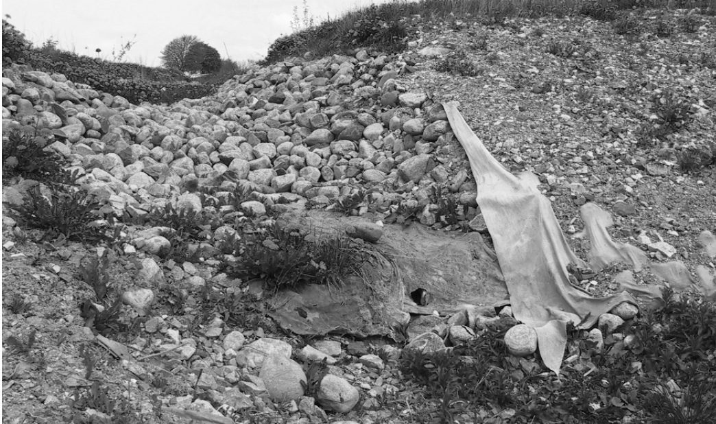
Figur 16. Bilden visar anslutningen av norrgående dike med kraftigt fall ner till damm 19. Bild tagen av Jesper Persson.
