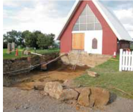
Grävningar för en ny entréväg, juli 2010.
