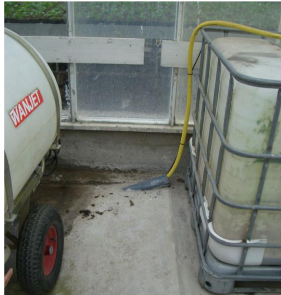
Figur 8. Arbetsplats med pumpgrop, ansluten till separat tank (foto: Klara Löfkvist).
