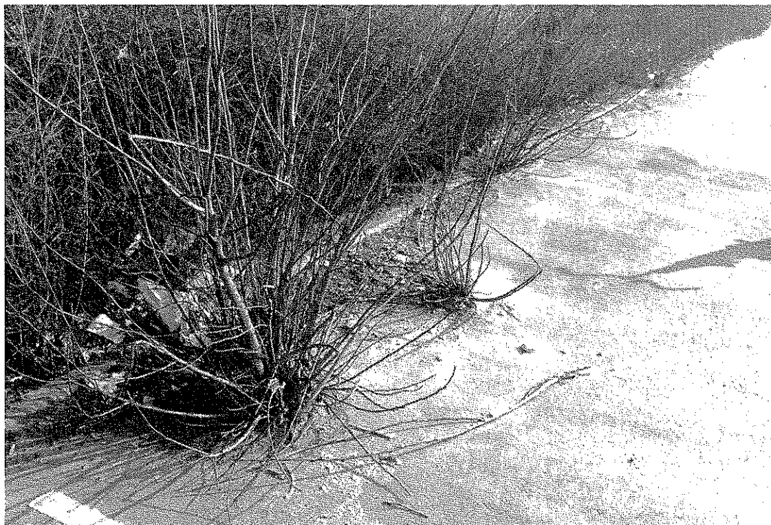
Bild 11 Rotskott från poppel förstör en parkeringsplats.
