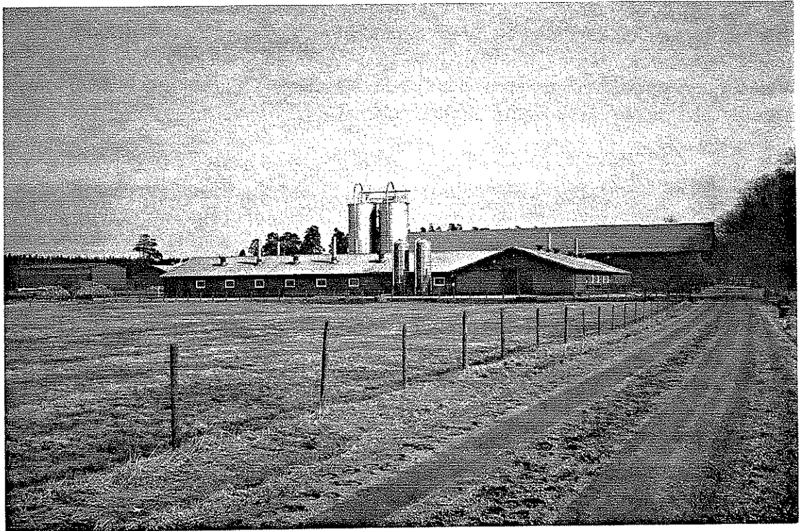
Figur 5: Befintligt svinstall på Uddetorp. Vy från syd-väst.
