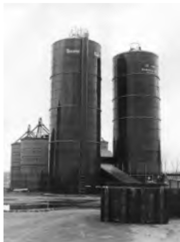
Figur 16. Vid Kungsängens ensilagelaboratorium används olika modellsilor; småsilor av glas med en volym på 1,7 l, rostfria silor på 10 l (foto: Rolf Spörndly ) och 3 m 3 modellsilor (foto: Bengt Everitt). På Kungsängen fanns även flera typer av ensilagesilor. I bilden längst ner syns silor av Harvestore-typ med bottentömmare samt Simplex med s. k. fylltömmare (foto: Ur institutionens arkiv).
