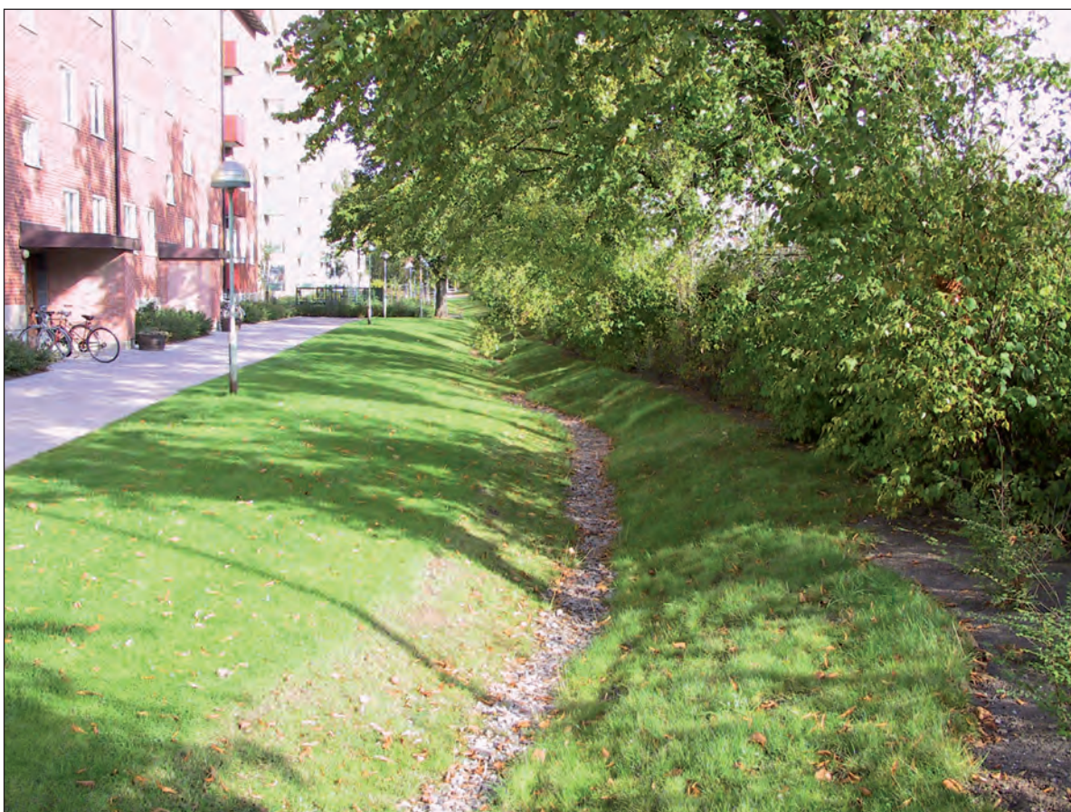
Bild 10. Ett svackdike är ett enkelt och effektivt sätt att hantera öppet dagvatten. Augustenborg, Malmö. (Foto: Tim Delshammar)
