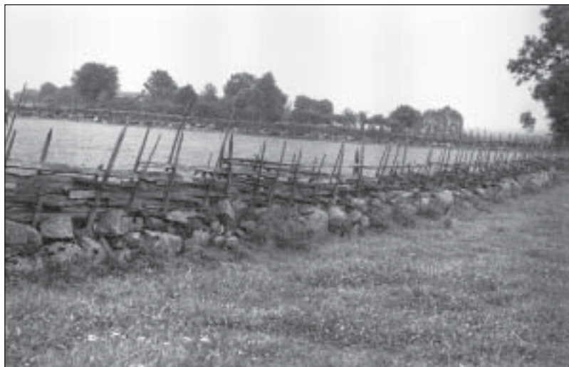
Figur 57. Gärdesgård stängd ovanpå en stenmur. Borgunda socken och Gudhems härad i Västergötland. E.U. 3959. Foto A. Boström 1931.
