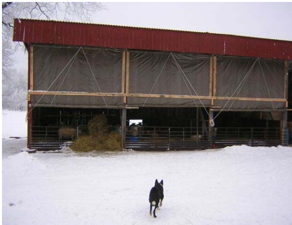
Figur 4:1 Alla tre byggnaderna har manuellt justerbara vindnät.
