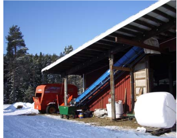
Figur 7:2 Foderinmatningen sker från mixervagn till en elevator på gaveln av byggnaden. Från elevatoren fylls fodret till fodervagnen.
