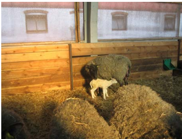
Figur 8:5 Den nedre delen av byggnaden är gjuten och innanför denna finns en trävägg som erbjuder en helt dragfri miljö upp till dryga metern och gränsar till vindnätet som finns längs långsidorna.
