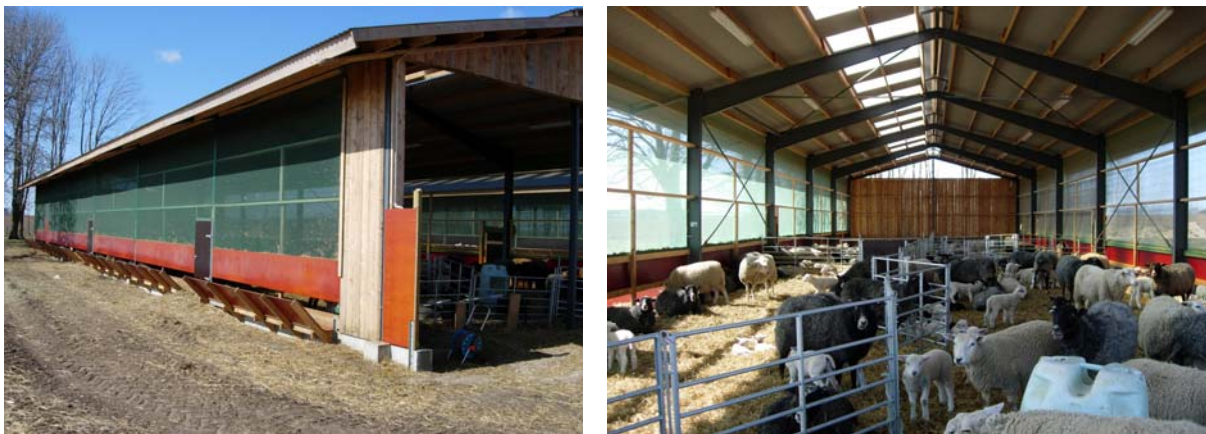
Figur 8. Utfodring utifrån i krubbor placerade längs långsidornas ytterväggar.
