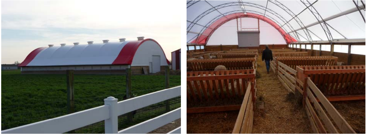
Figur 14. Exempel på bågkonstruktion ("Hoop barn") för lammproduktion i Illinois, USA.
