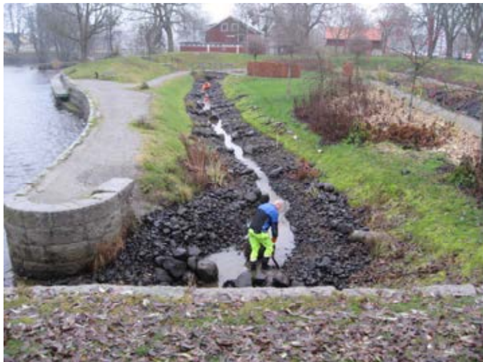
Bild 134. Detta dike med en rännil har i normala fall en betydligt större vattenföring och bildar ett omlöp, det vill säga en vattenpassage, runt slussen i Svartån, Örebro, strax öster om stadens centrum. Omlöpet fyller flera funktioner: det möjliggör för vattenorganismer att passera förbi slussportarna, det har en renande funktion av åns vatten, det drar till sig växter och djur som gynnas av mindre strömmande vatten och inte minst så är det är ett mycket populärt rekreativområde, eftersom vatten har fascinerat människor i alla tider.
