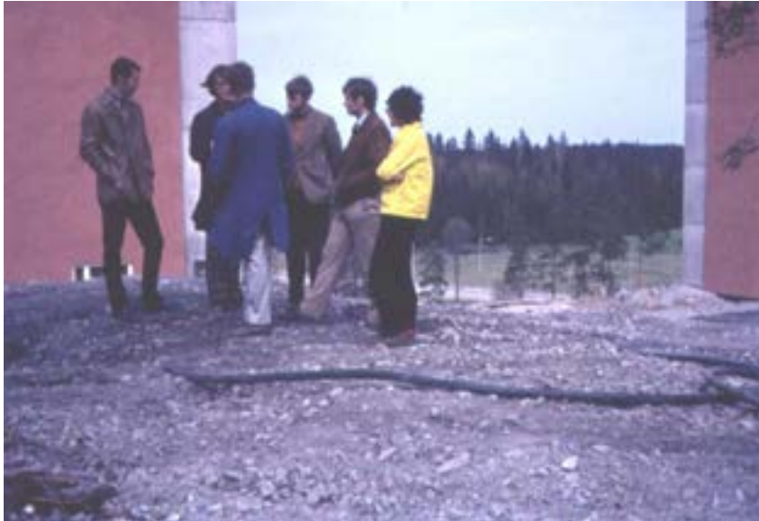
Bild 6. Rune Andersson till vänster. Erik Skyes ryggtavla döljer det mesta av Clas, Pär Söderblom, en för närvarande okänd, eller var det Bengt Rosén? Margitta Nordh i gul jacka. Diabilden bär märkningen Hjulsta-Tensta. Årtalet var 1975 och vi var inne på tredje säsongen av projekttiden.
