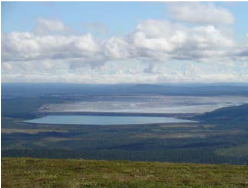
Bild 16. Sandmagasinet sett från Dundret. Hitom det silverfärgade magasinet ligger en klarningsjö. Magasinet yta är cirka 1400 hektar.
