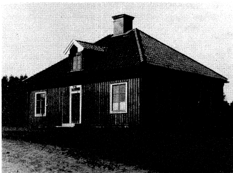
Fig. 39. Bogesunds försöksfält: Huvudbyggnaden på Rösckär.
