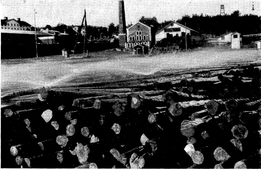
Fig. 1. Vattenbesprutning av sågtimmer enligt RUNBÄCK för motverkande av sprickbildning och lagringsskador genom svampar. Sund, juli 1944.
