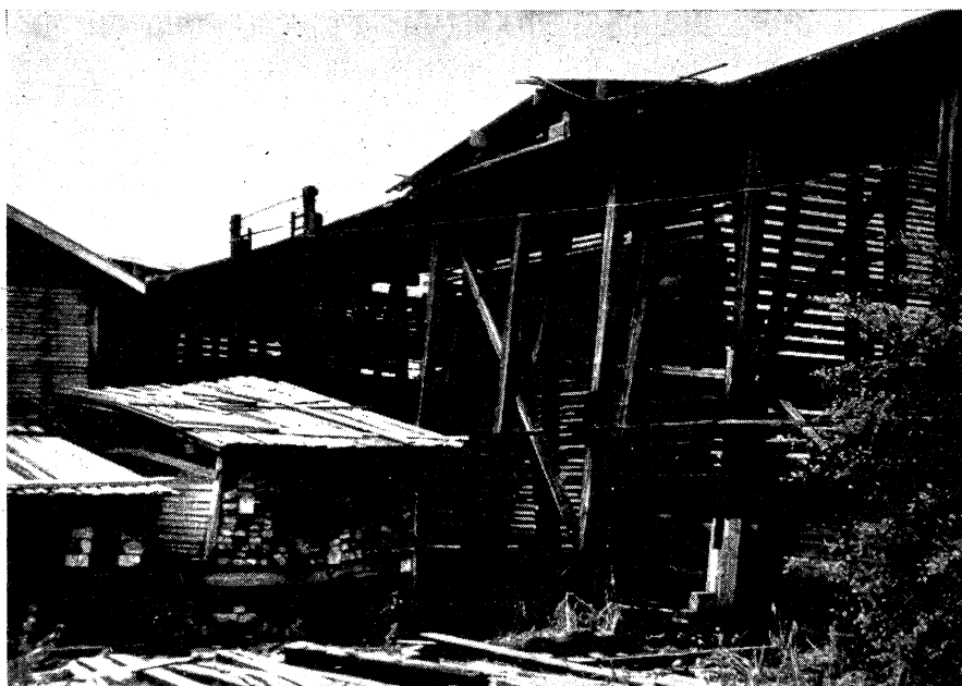
Fig. 4. Bild från brädgård D , där högbanor och vegetation mellan staplarna ge dessa ett »instängt» läge, som medför dåliga torkningsbetingelser. 1944.
