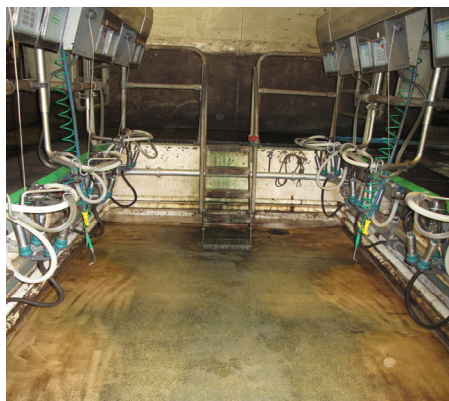
Bild 13. Mjölkgrup med betonggolv.
