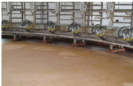
Bild 14. Betonggolv i mjölkkningskarusell
