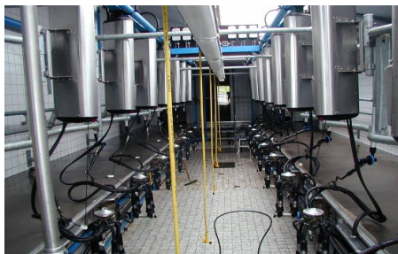
Bild 12. Mjölkgrup med klinkergolv.
