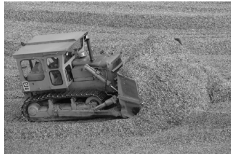
Figur 4 Bulldozer i arbete
