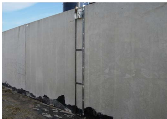
Figur 2. Mätpunkternas placering i silon för pressvattenrör och mätstegar.
