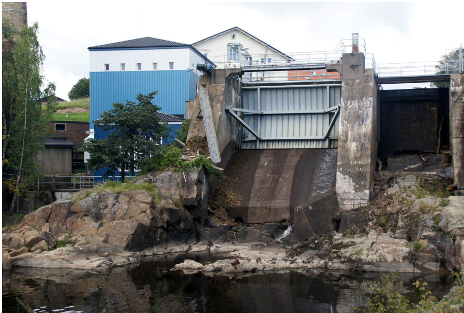
Kraftverket i Hedefors som det ser ut idag. Foto: Erik Degerman.
