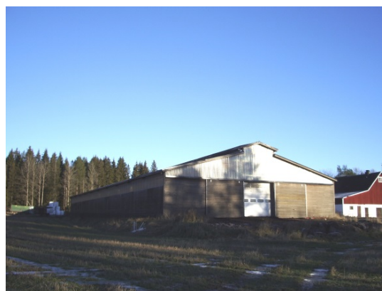
Fårstall med plats för 400 tackor, byggt 2009. I den f.d. lagården finns plats för flasklamm mm.
