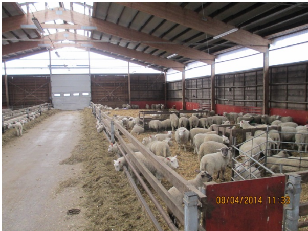
Foderbord av betong där fullfodervagnen kan köras.
