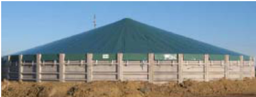
Biogödselbrunn. Bild: NSR
