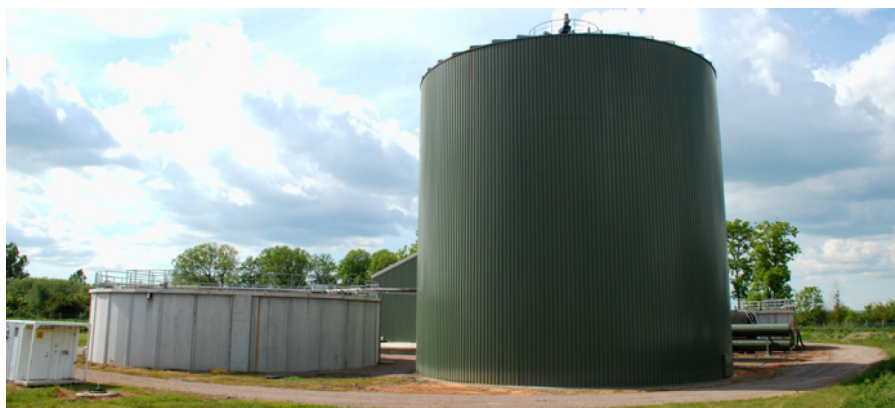
Gårdsbaserad biogasanläggning. Bild: Biogas Syd
