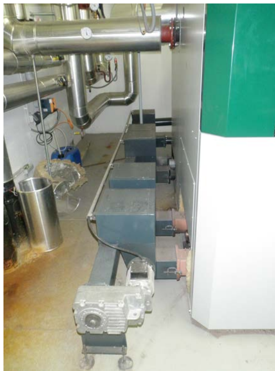
Figur 13. Askutmatning med skruv från större flispanna i Österrike. Askan matas ut till behållare på utsidan.
